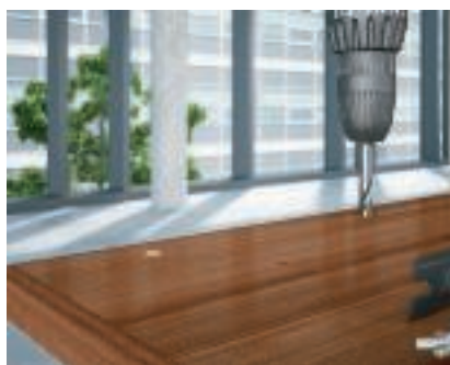
Vorbereitung für Befestigungs-Set, Tischmontage Für die Montage des Befestigungs-Sets sind Bohrungen (Ø 10 mm) in der Tischplatte erforderlich.
