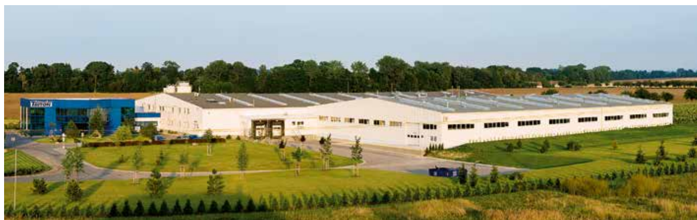
2009 – Foto von Stary Mateřov zur fertiggestellten Halle Nr. 2
