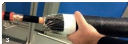
Der Körper wird in der Verbindungsmittle positioniert
