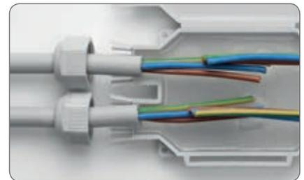
Kabelverschraubungen auf Kabel aufziehen, Kabel einlegen
