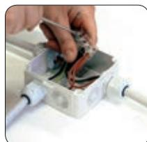
Kabel einführen und anschließen.
