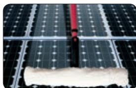
Je nach Verschmutzungsgrad einige Minuten einwirken lassen. Mit einem weichen Tupfer oder einem weichen, nicht-scheuernden Schwamm (angefeuchtet) einreiben.
