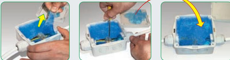
Dank Magic Power Gel kann der Kasten **wieder geöffnet, kontrolliert** und mit demselben, zuvor entfernten Gel wieder **isoliert** und verschlossen werden.
