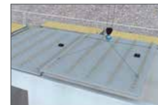
Les plafonds préfabriqués sont posés sur le chantier.
