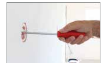
Enfin, enlever le couvercle cache-plâtre avec un tournevis.
