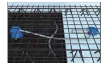
L'armature en acier est posée et le béton est coulé.
