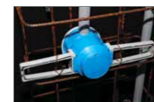
Montage en tant que grand boîtier électronique avec ailes.
