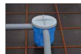
Montage en tant que grande boîte de plafond.
