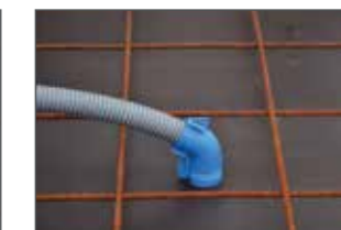
Enficher le coude sur la partie inférieure.
