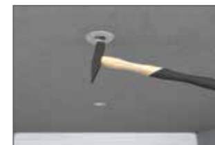
Enfoncer le couvercle avec un marteau.
