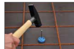
Clouer la partie inférieure sur le coffrage.
