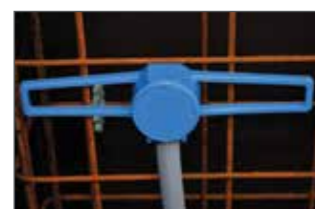
Pour un plafond en béton de plus de 20 mm, tourner simplement le boîtier.
