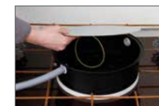
Introduire les tubes/câbles et fixer la plaque de tôle avec des serre-câbles.
