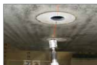
Des ouvertures individuelles peuvent être alésées.
