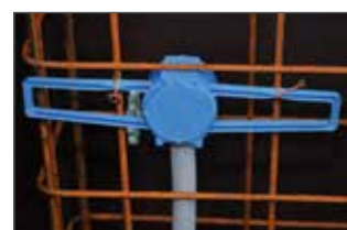
Introduire le tube et le lier simplement sur l'armature en acier.
