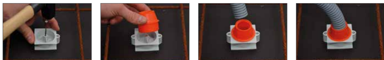
Clouer la partie inférieure sur le coffrage.
