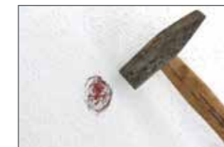
Frapper légèrement sur le couvercle cache-plâtre avec un marteau.
