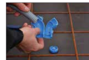
Emboîter un tube M20 ou M25.
