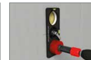
Ensuite, scier au travers des alvéoles existantes.
