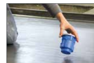
1. Variante : Coller avec de la colle thermofusible sur la table de coffrage.
