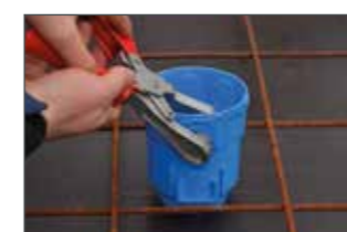
Fixer la boîte universelle avec des clous sur le coffrage. Emboutir le trou avec une pince à encocher.
