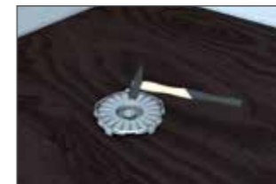
Fixer le couvercle avec des clous sur le coffrage.
