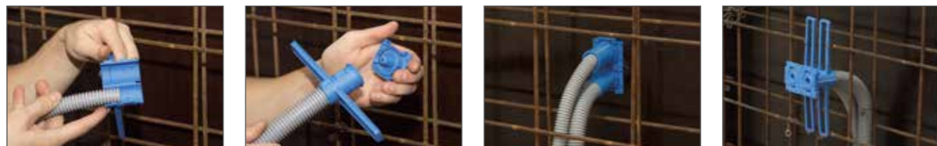
Emboîter un tube M20 ou M25.
