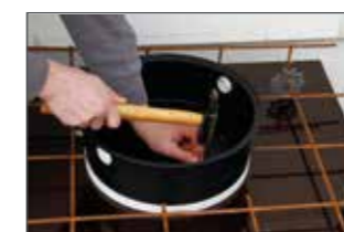
Pour le béton coulé sur place, clouer sur le coffrage, dans un élément préfabriqué, coller sur la table de coffrage.
