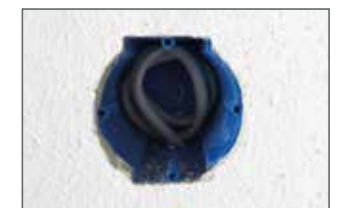
25 secondes pour 5 boîtes aléser et enlever le couvercle.
