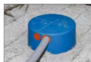
Insérer un tube M20 ou M25.
