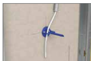
Coller et passer le câble.
