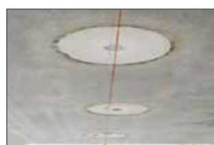
Tracer une ligne, imprécisions facilement corrigibles par le Ø 190 mm.
