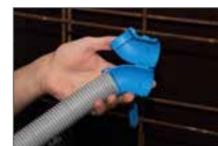
Emboîter un tube M32 ou M40.
