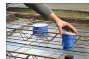
2. Variante : Positionner sur la table de coffrage avec un aimant.
