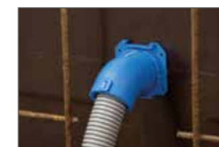
Montage avec clous sur le coffrage.
