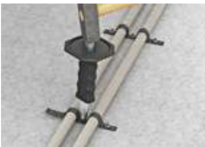
Rohrfixierung mit FixPin und Metallmontageband
