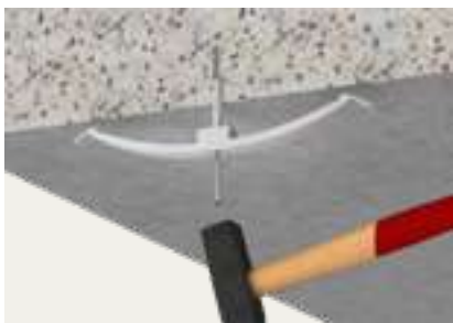
Einschlagen in die Decke
