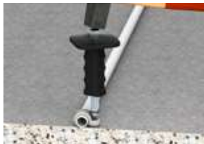
Mit dem Setzeisen einschlagen
