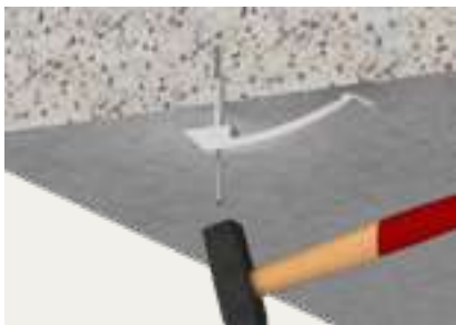
Einschlagen in die Decke
