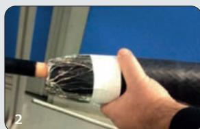
2 Die Verbindung wird auf das angeschlossene Kabel aufgesteckt
