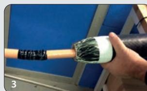
3 Der Körper wird in der Verbindungsmitte positioniert
