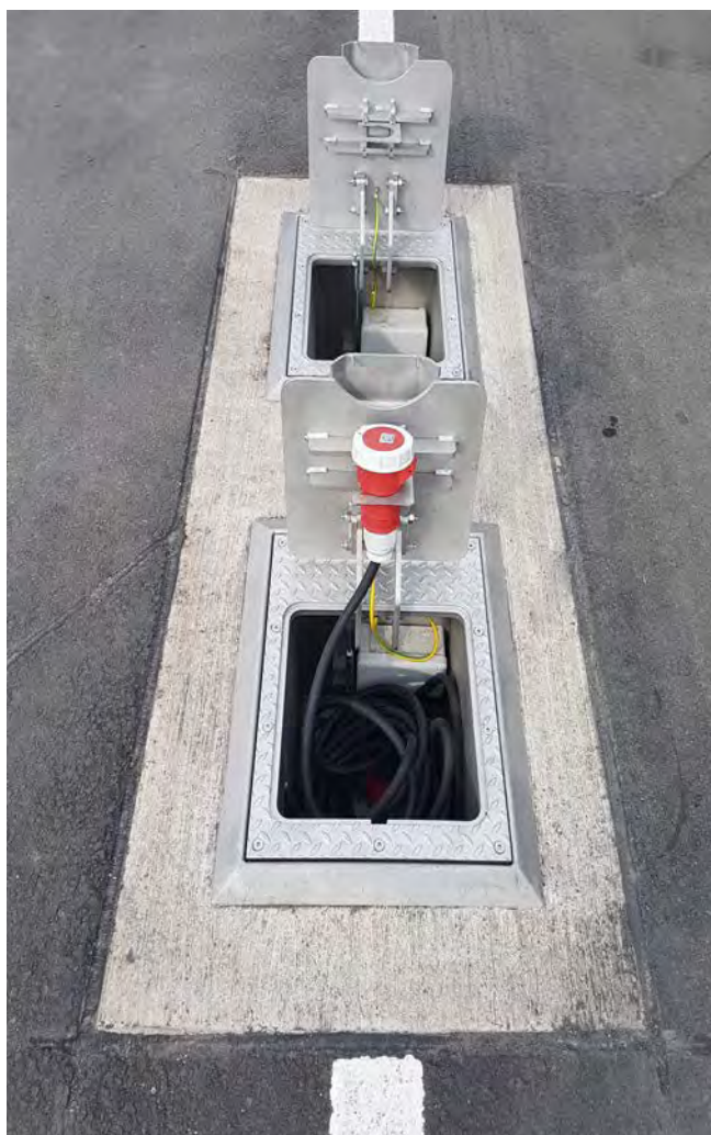
Steckerschacht für Kühlfahrzeuge, ab Seite 238
