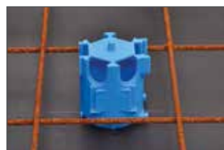
Dosenkörper auf Deckel aufdrücken.
