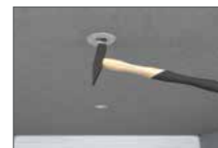
Deckel mit Hammer einschlagen.
