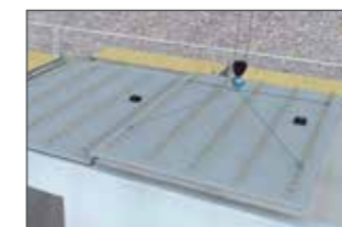
Fertigteildecken werden auf der Baustelle verlegt.
