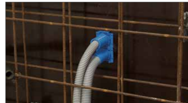
Montage mit Nägeln auf der Schalung.
