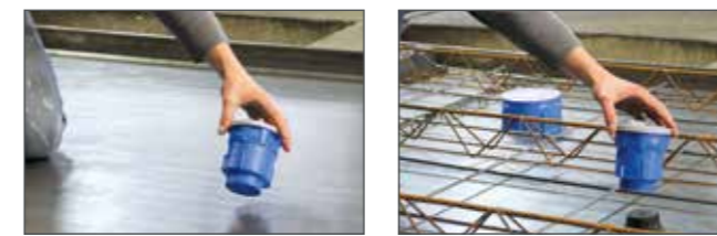
1. Variante: Mit Heißkleber auf Schaltisch kleben. 2. Variante: Mit Magnet auf Schaltisch positionieren.
