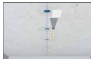
Mit einem Lochschneider wird die individuelle Öffnung ausgebohrt und an die Mineralfaserplatte angespachtelt.
