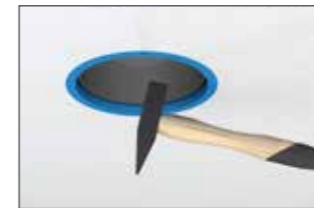
Lüftungshülse von unten mit Hammer einschlagen.
