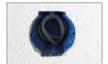
25 Sekunden für 5 Dosen ausbohren und Deckel entfernen.
