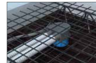
Obere Bewehrung einbringen und betonieren.
