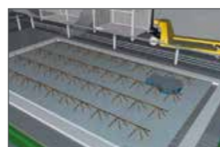
Betonfertigteile werden gegossen.
