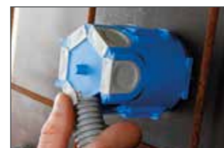
Rohr mit Quick-Fix-Schieber einschieben und schließen.
