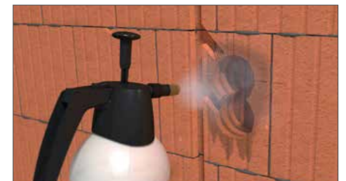
Bohrung anfeuchten, Schaum quillt dadurch noch besser auf.
