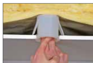
Schutzkappe in Bohrloch einschieben.
