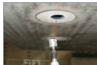
Individuelle Öffnungen können ausgebohrt werden.
