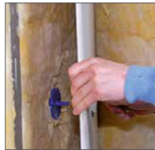
Der Trockenbauer schlägt mit dem Hammer ein Loch aus und läßt den Mitteldorn durchstehen.
