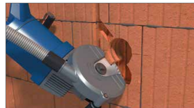
Schlitz bis in das Dosenloch fräsen.
