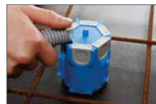
Rohr mit Quick-Fix-Schieber einschieben und schließen.
