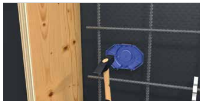
Deckel wird mit zwei Nägeln auf Schalung genagelt.
