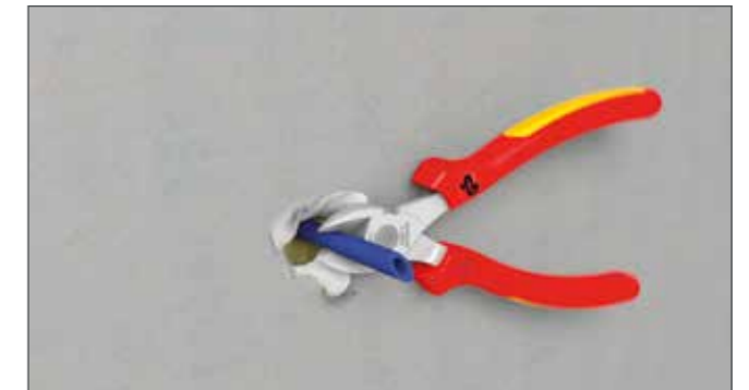
Leitungsträger mit Zange bündig zur Wand abzwicken.
