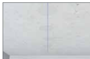
Fertigmontage: Fluchtlinie anzeichnen, Ungenauigkeiten können jetzt korrigiert werden.
