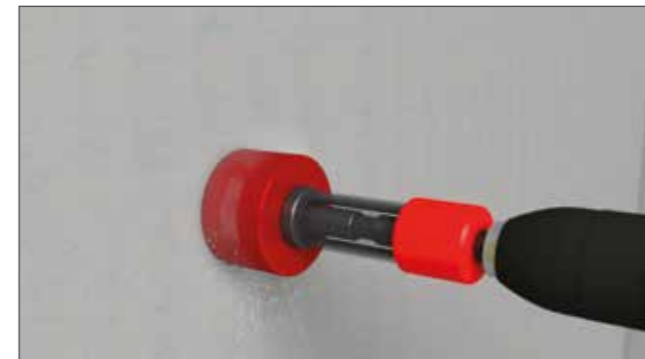
Mit Dosenfräser Loch ausfräsen.
