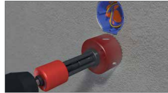
...oder mit einer Bohrkrona aufgebohrt werden.
