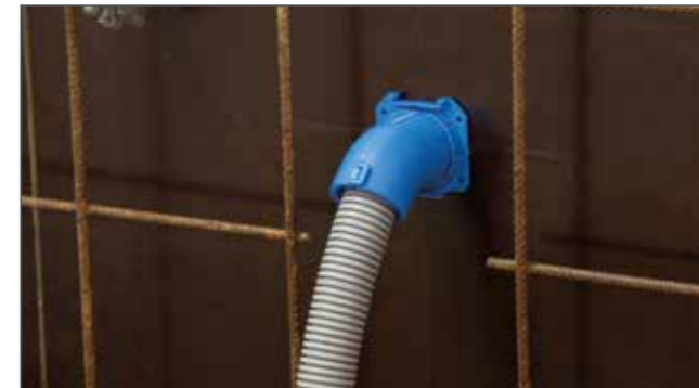
Montage mit Nägeln auf der Schalung.
