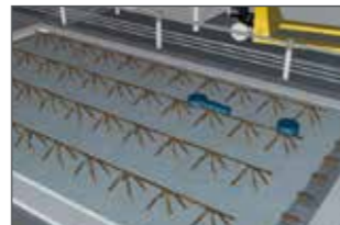
Stahlarmierung wird eingebracht und der Beton gegossen.
