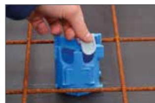
Nicht benötigte Öffnungen mit Schieber schließen.
