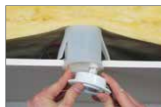
Strahler montieren.
