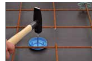
Leuchtausslassdose 35 mm aufnageln.
