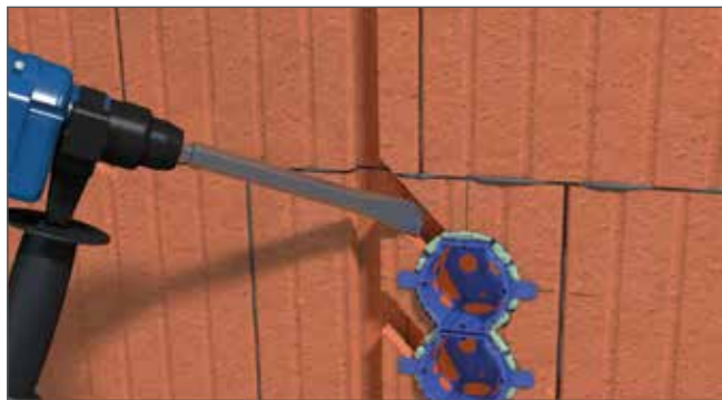
Bei ausgehärtetem Schaum den verbleibenden Steg ausbrechen.
