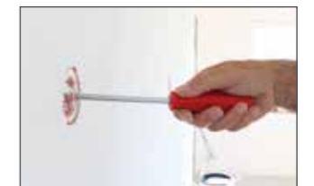
Zum Schluß mit einem Schraubenzieher den Putzdeckel entfernen.
