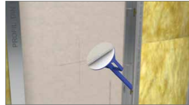
Klebescheibe aufkleben, Schutzfolie abziehen.
