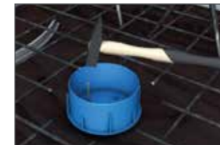
Lüftungshülse auf die Schalung nageln.
