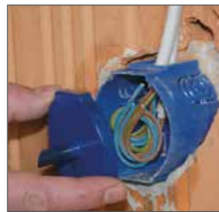
Bohrdeckel aufdrücken.
