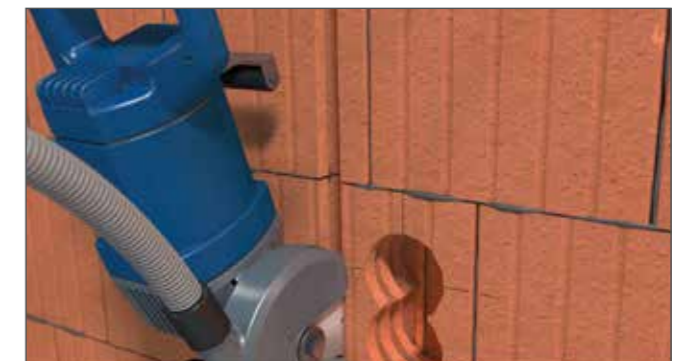
Schlitz mit Mauernutfräse entlang der Bohrungen fräsen.
