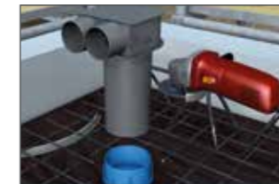
Deckenstützen auf die gewünschte Länge kürzen.
