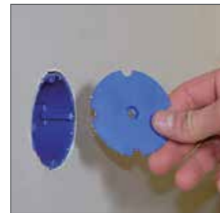
Dosendeckel entfernen – fertig!
