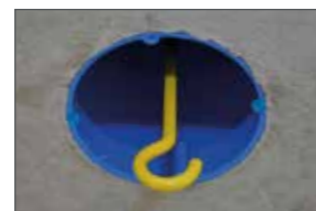
Deckenverbindungsdose mit Aufnahme für Deckenhaken. (Maximale Belastung 10 kg).
