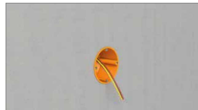
Hohlwanddose montieren und Einbaugerät/Steckdose installieren.
