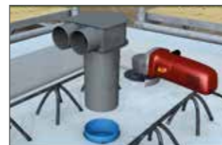
Stützen auf gewünschte Länge kürzen und in Hülse einschieben.
