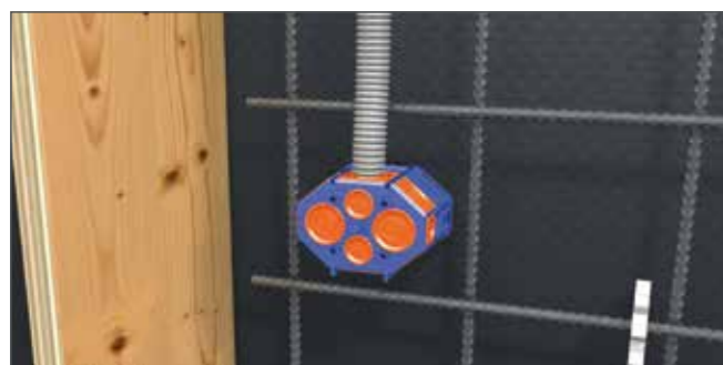
Membrandose wird auf Deckel gesteckt.
