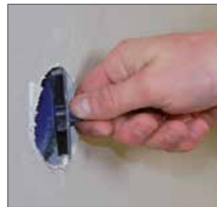
Leichtes Rausnehmen des durchfrässten Bohrdeckels.
