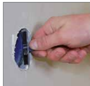
Leichtes Rausnehmen des durchfrässten Bohrdeckels.
