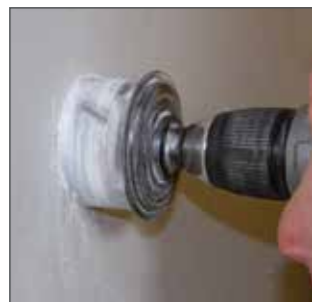
Ohne erneutes Messen der Montagestelle können Sie jetzt das Dosenloch fräsen.
