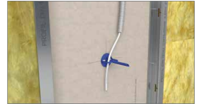
Leitungen oder Rohre durch die Bügel führen. Leitungsträger aufkleben und...
