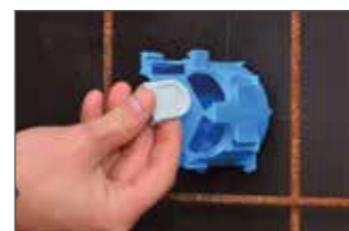
Nicht benötigte Öffnungen mit Schieber schließen.
