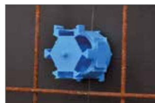
Dosenkörper auf Deckel aufdrücken.
