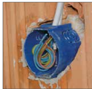
Dosenunterteil setzen...
