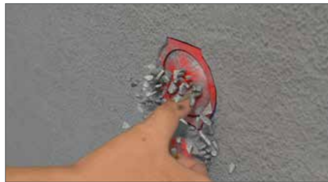
Putzdeckel kann mit der Hand eingedrückt werden...
