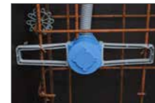
Leuchtausslassdose Ø 35 mm mit Flügel montiert.
