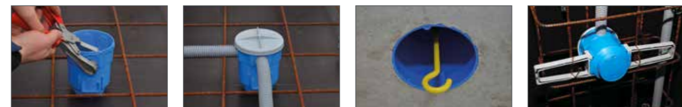
Universaldose mit Nägeln auf die Schalung fixieren. Loch mit Stanzzange ausstanzen. Montage als Deckengrößdose. Montage mit Deckenhaken. (Maximale Belastung 10 kg). Montage als Elektronikgrößdose mit Flügeln.
