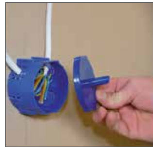
Bohrdeckel aufdrücken.
