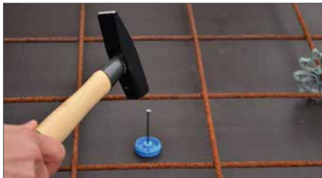
Unterteil auf Schalung nageln.
