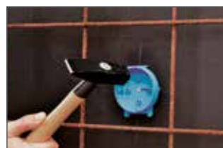
Gerätedeckel oder Leuchtausslassdeckel mit Nägeln auf der Schalung befestigen.
