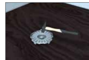
Deckel mit Nägeln auf der Schalung befestigen.
