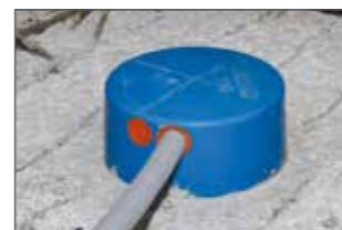
M20 oder M25-Rohr einschieben.
