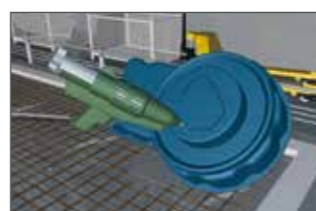
XL 300 Flexgroßdose mit Heißkleber auf den Schaltisch kleben.
