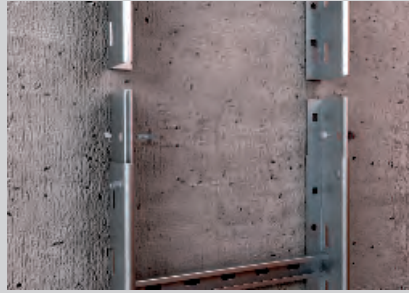
Stoßstellenverbindung mit verschraubtem Verbinder.
