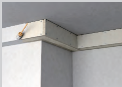
Abschließende Oberflächenbehandlung durch Streichen oder Tapezieren.
