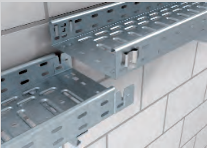
Erstellen der Längsverbindung durch Ineinanderstecken der Kabelrinnen.
