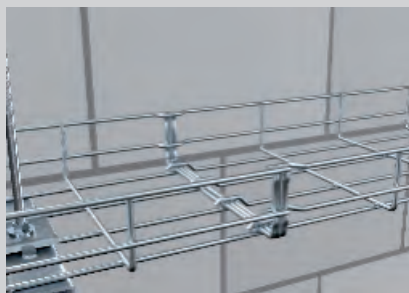
Fertige schraubenlose Stoßstellenverbindung.
