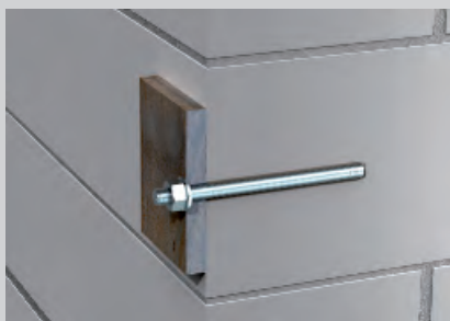
Ankerstange montiert in Kalksandvollstein ohne Siebhülse.
