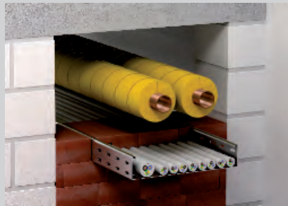
Durchgeführte nicht brennbare Rohre mit Streckenisolierung.
