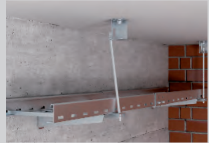
Deckenbefestigung der Gewindestangen mit Brandschutzbügel.
