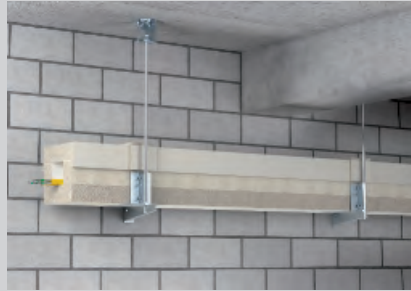
Wandmontage auf Auslgern und zusätzlicher Gewindestangesicherung.
