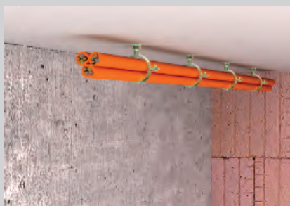
Gebündelte Kabelverlegung unter der Decke.
