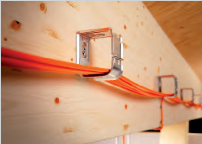
Kabelverlegung mit Sammelhalterung seitlich am Holzbalken.
