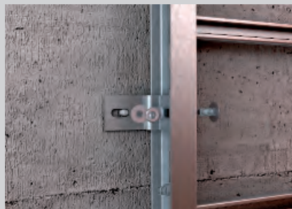
Montage mit verschraubten Befestigungswinkeln.
