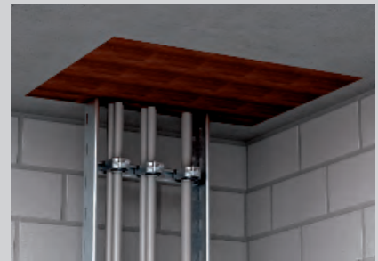
Strammsitzender Einbau der Blöcke im Deckendurchbruch.
