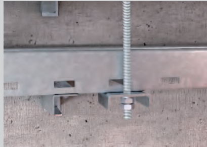
Befestigung der senkrechten Gewindestange am Anschlussbauteil.
