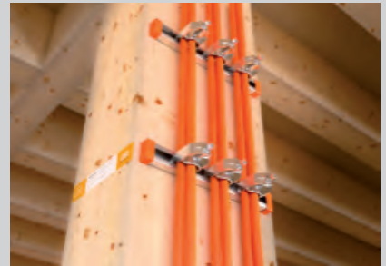
Senkrechte Kabelverlegung mit Schienen und Schellen am Holzbalken.
