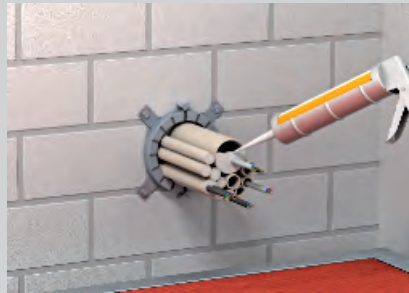
Verschließen der Rohrenden mit Dämmschichtbildner DSX.
