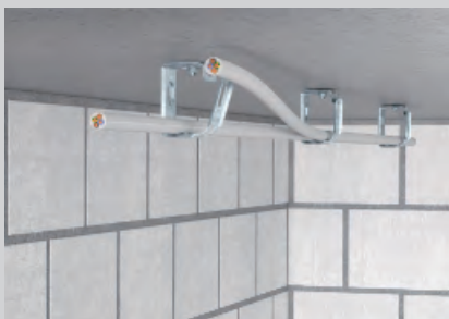
Öffnen der Sammelhalterung und Einlegen der Kabel.
