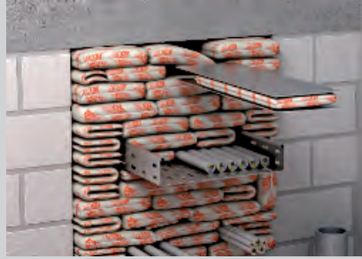
Bleche als Montagehilfe für die letzte Kissenschottlage.
