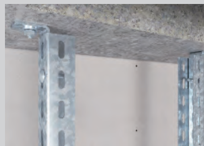
Deckenbefestigung der Leiterholme mit angeschraubten Montagewinkeln.
