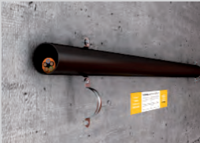
Einlegen in die Schraubabstandscheibe durch Einhaken des Oberteils unter die Schraube.
