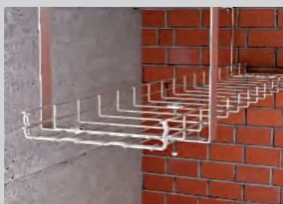
Befestigung der Gitterrinne mit Klemmstück und Flachrundschrauben.
