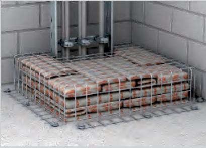
Sicherung gegen Abrutschen oberhalb des Fußbodens.
