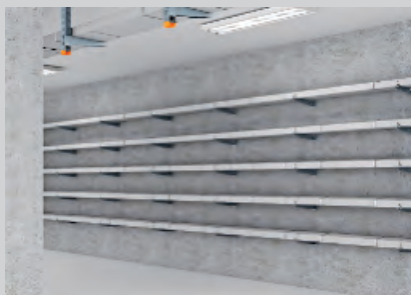
Kabeltunnel mit Bandagen in Kraftwerken.
