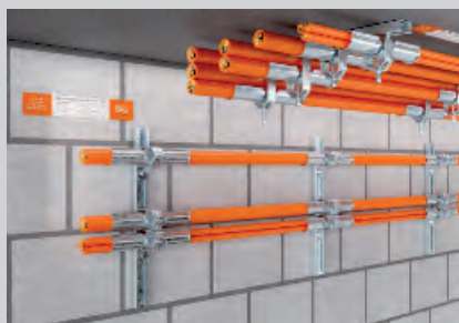
Waagerechte Montage mit Bügelzellen und Langwannen an der Wand und unter der Decke.
