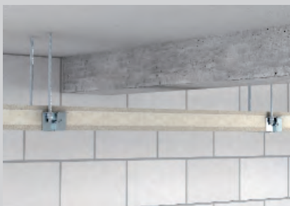
Abgehängte Montage an den Verbinderelementen.
