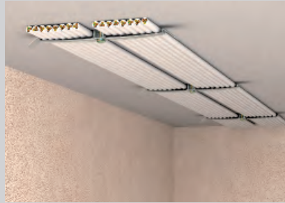
Deckenmontage mit Kabelklammer 2033 M.
