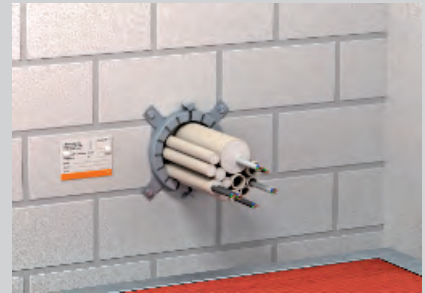
Gekennzeichnete Abschottung von Installationsrohrbündeln.
