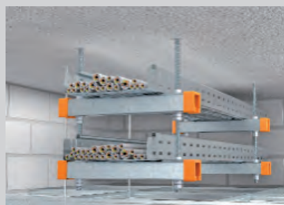
Zweilagige Deckenmontage auf Montageschienen.
