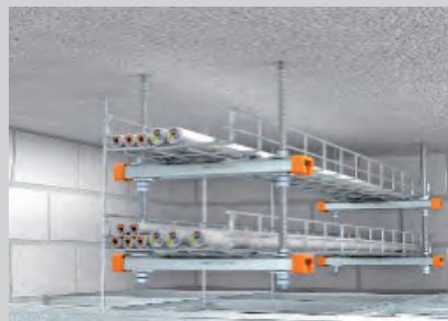
Zweilagige Deckenmontage auf Montageschienen.
