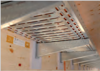
Auslegermontage seitlich am Holzbalken mit hinterlegter Brandschutzplatte.
