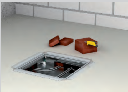
Schmale Streifen für die Kanalzüge zuschneiden.
