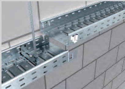
Erstellen der Längsverbinding durch Ineinanderstecken der Kabelrinnen.
