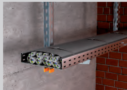
Bandagierung der Kabelbündel auf Tragsystemen.
