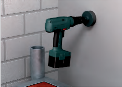
Bohren eines Lochs mit einem Dosenbohrer.
