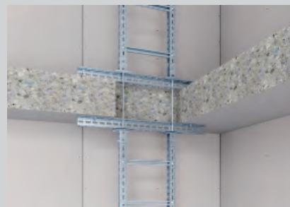
Montage der Steigeleiter im direkten Verlauf unter einer Deckenöffnung mit Querprofilen und Kopfplatten.
