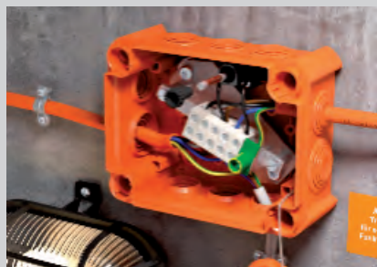
Kabeleinführung mit Einsteckdichtungen.
