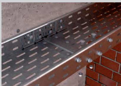
Längsverbinder und Stoßstellenleiste mit Flachrundschrauben befestigen.
