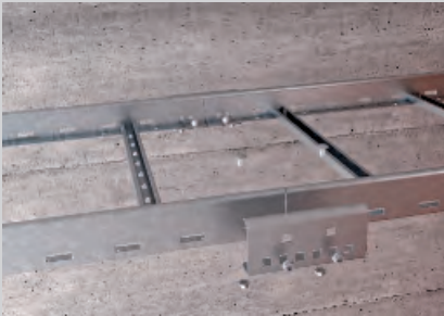
Montage der Längsverbinder mit Flachrundschaublen.
