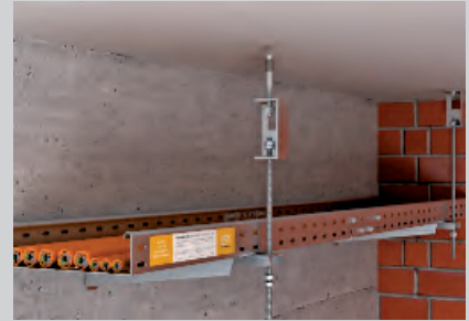
Deckenbefestigung der Gewindestangen mit Brandschutzbügel.
