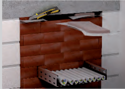
Vakuumblocke für einfachen Restspaltverschluss.
