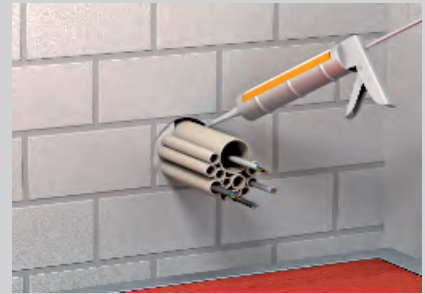
Verschließen der Ringspalte mit Dämmschichtbildner DSX.
