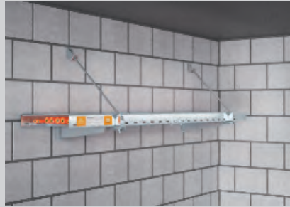
Wandmontage mit Gewindestangensicherung schräg.
