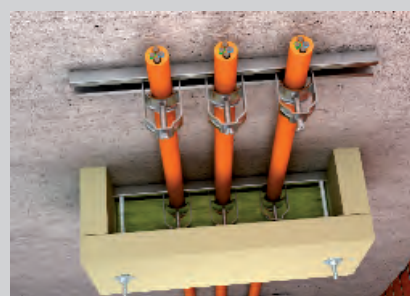
Wirksame Unterstützungsmaßnahme mit der Zugentlastung ZSE90.
