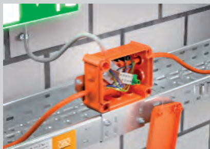
FireBox montiert mit Montageplatte an Kabelrinne.
