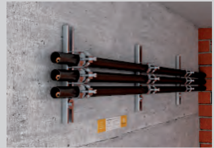
Platzsparende Installation mehrerer Rohre nebeneinander mit Bügelschellen.
