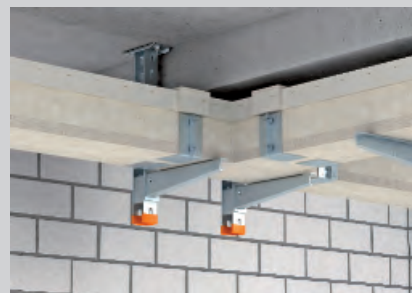
Vormontierte Standardformteile im Trassenverlauf.
