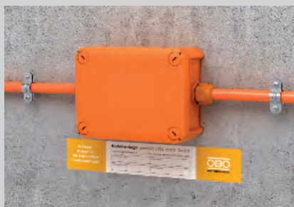
Fertig installierte FireBox mit Kennzeichnungsschild.
