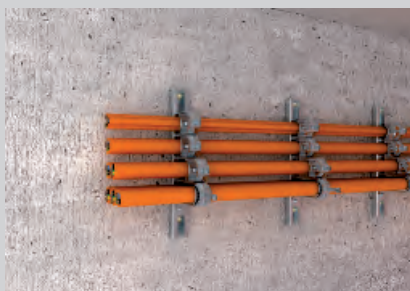
Waagerechte Montage der Kabel mit Bügelzellen an der Wand.
