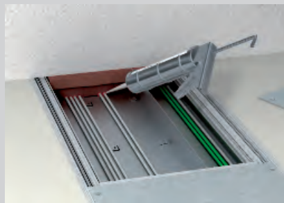
Fugen und Zwickel zwischen den installierten Kabeln und den Blöcken mit der Brandschutzmasse FBA-SP mindestens 2 cm tief verschließen.
