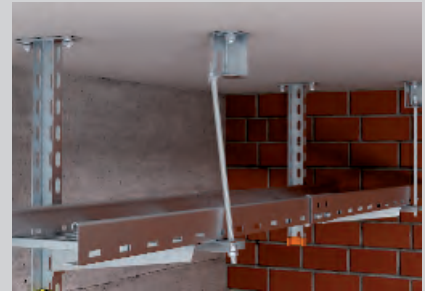
Einhängen der Gewindestange in den Brandschutzbügel.
