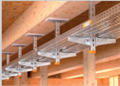
Hängestielmontage unter dem Holzbalken mit hinterlegter Brandschutzplatte.
