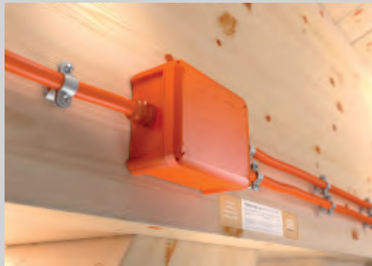
Montage der OBO FireBox am Holzbalken.
