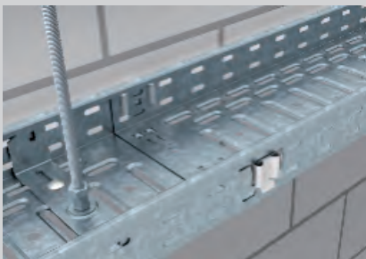
Fertige schraubenlose Stoßstellenverbindung.
