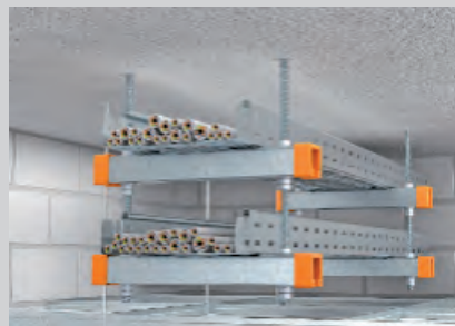
Zweilagige Deckenmontage auf Montageschienen.
