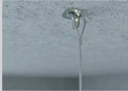
Einfache Montage des Tragseils mit vormontiertem Universalwinkel unter der Decke.
