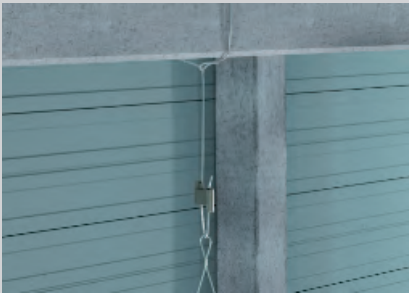
Dübellose Befestigung des Trageils mit Schlaufe an einem Betonträger.
