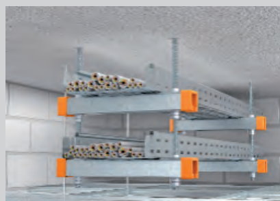
Zweilagige Deckenmontage auf Montageschienen.
