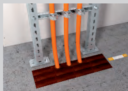
Verschluss der Deckenöffnung mit einem zugelassenen Abschottungssystem.
