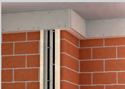
Kabelbefestigung bei senkrechter Kanalmontage mit Schellen.
