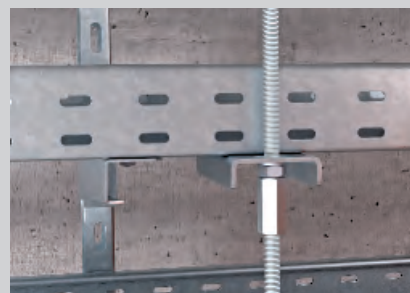
Gewindestangenbefestigung an der Rinne bei mehrlagiger Anordnung.
