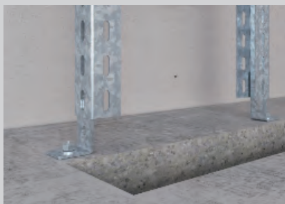
Auf dem Boden montierte Kopfplatten zur Lagesicherung der Leiterholme.
