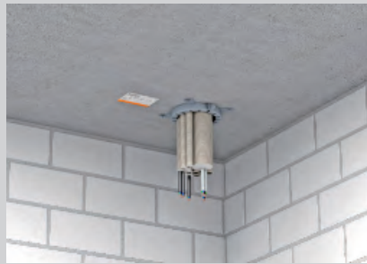
Montage an der Deckenunterseite mit Metalldübeln.
