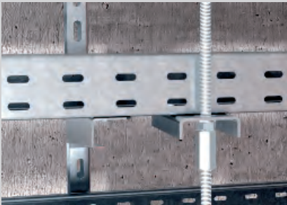
Gewindestangenbefestigung an der Kabelrinne bei mehrlagiger Anordnung.
