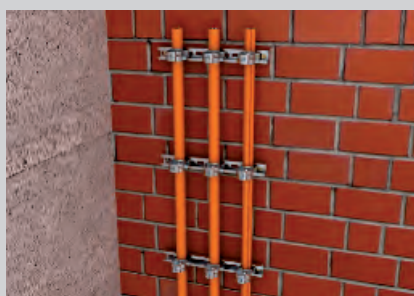
Senkrechte Montage der Kabel mit Bügelzellen an der Wand.
