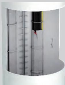
Bandagierte Steigetrasse im Turm einer Windkraftanlage.
