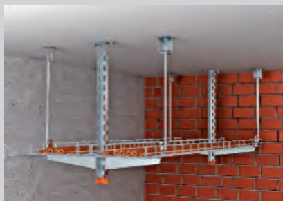
Deckenmontage mit beidseitig angeordneten Auslegern.
