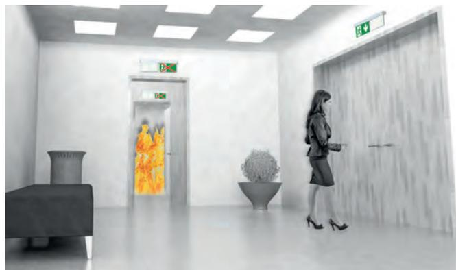
Wird ein Brand durch die Brandmeldeanlage detektiert, können die Pfadfinder-Leuchten flüchtende Menschen sicher aus der Gefahrenzone leiten. Hierzu wird der alternative 2. Fluchtweg ausgewiesen. Die Kennzeichnung des 1. Fluchtweges in den Gefahrenbereich ist nun blind.
