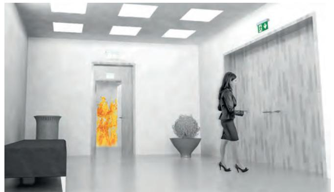
Wird ein Brand durch die Brandmeldeanlage detektiert, können die Pfadfinder-Leuchten flüchtende Menschen sicher aus der Gefahrenzone leiten. Hierzu wird der alternative 2. Fluchtweg ausgewiesen. Die Kennzeichnung des 1. Fluchtweges in den Gefahrenbereich ist nun blind.
