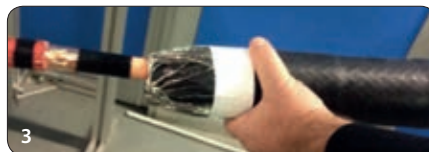
Der Körper wird in der Verbindungsmittle positioniert
