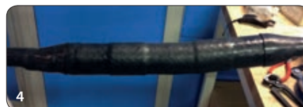
Die Verbindung ist fertig und kann sofort unter Spannung gesetzt werden
