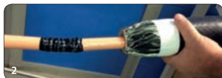
Die Verbindung wird auf das angeschlossene Kabel aufgesteckt
