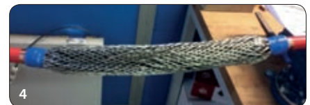
4 Metallabschirmung wieder herstellen
