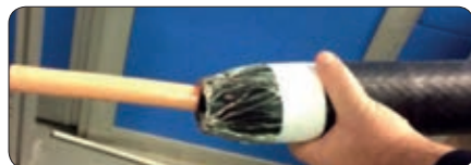
Der Verbindungskörper trägt den eingebauten Schirm und die Außenhülle
