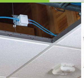
Das Deckensystem bietet einen festen Standort für Datenanschlüsse in Lüftungsbereichen und schafft eine zuverlässigere und einheitlichere Verbindung als ein direkter Verbindungsstecker. Diese feste Verbindung reduziert zudem die Möglichkeit etwaiger Beschädigungen während der Bauausführungen.
