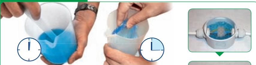
Die Komponenten in den Messbecher gießen, mischen und vernetzen lassen (etwa 15 Minuten). Die Isolierung entfernen und in kleinen Stücken um den Anschluss herum positionieren, so dass dieser vollständig bedeckt wird. Natürlich kann die von früheren Mischungen aufbewahrte Isolierung verwendet werden.
