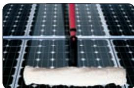
Je nach Verschmutzungsgrad einige Minuten einwirken lassen. Mit einem weichen Tupper oder einem weichen, nicht-scheuernden Schwamm (angefeuchtet) einreiben.
