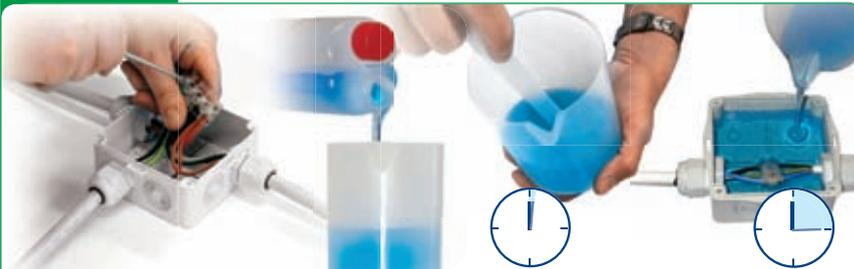
Die Isolierung Magic Power in der Zweikomponenten-Flasche im Verhältnis 1:1 mischen und in den im Kit enthaltenen Kasten gießen, um die Anschlüssen innen zu schützen und zu versiegeln. Das Gel vernetzt in nur etwa 15 min. aber der Kasten kann sofort mit Strom versorgt werden.
