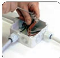
Kabel einführen und anschließen.
