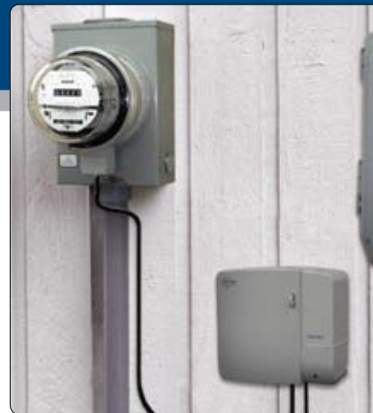
FTTP ONT UPS System
