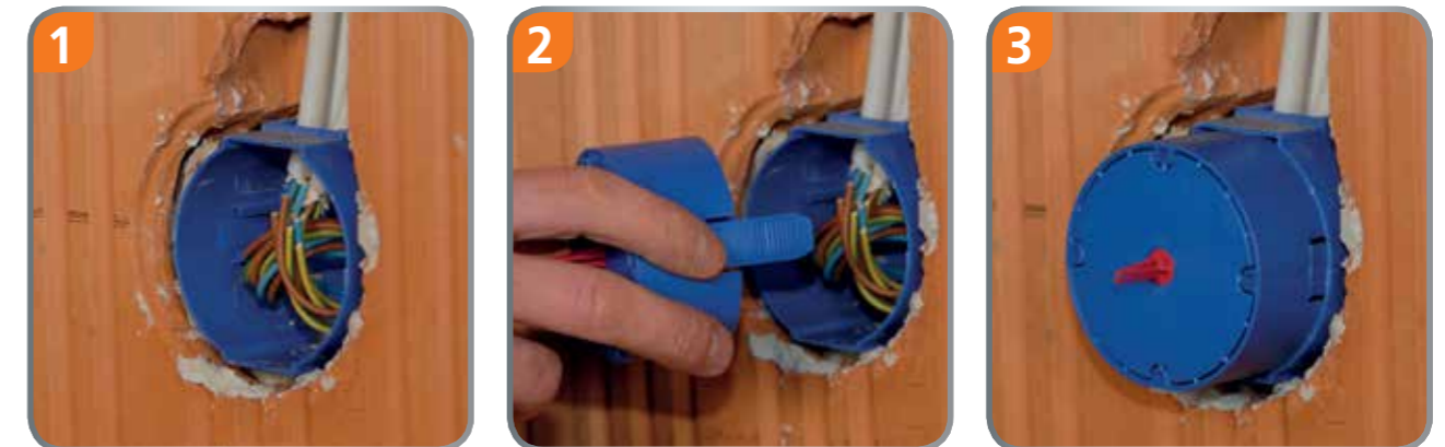
1 Unterteil bündig setzen. Elektrokabel oder Rohre einbringen. 2 Dosendeckel einrasten lassen. 3 Deckel steht noch ca. 2,5 - 3 cm vor.
