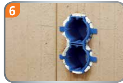
6 Schaum verteilt sich gleichmäßig, durch die seitlichen Laschen. Bei Außenwänden bitte ganz umschäumen (wärmebrückenfrei).
