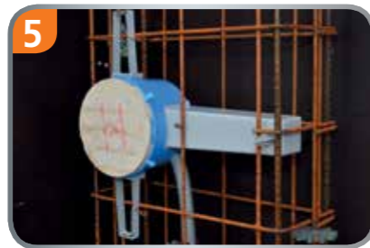
5 Montage mit Flügeln und Trafotunnel.
