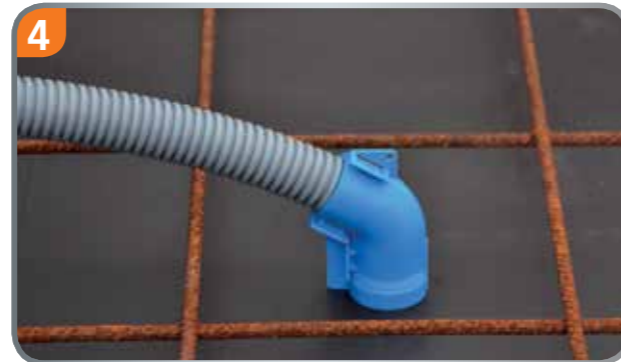
4 Auf das Unterteil stecken. Absolut sichere Zugentlastung!
