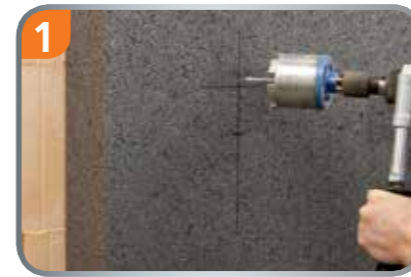
1 Erste Dose anzeichnen und mit Ø 82 mm Bohrkronen ausbohren.
