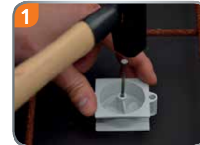
1 Unterteil auf Schalung nageln.
