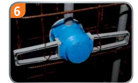
6 Montage als Elektronikgroßdose mit Flügeln.
