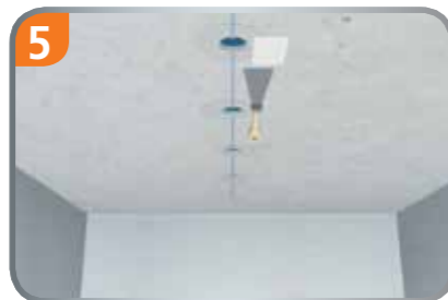
5 Mit einem Lochschneider wird die individuelle Öffnung ausgebohrt und an die Mineralfaserplatte angespachtelt.
