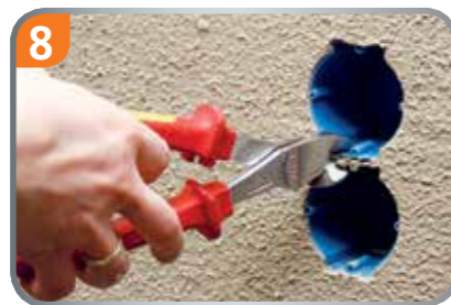
8 Nach dem Verputzen wird der SCS-Verbindungssteg ausgebrochen.
