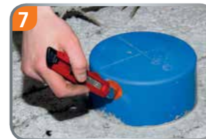
7 TPE-Öffnung mit Cuttermesser einschneiden.
