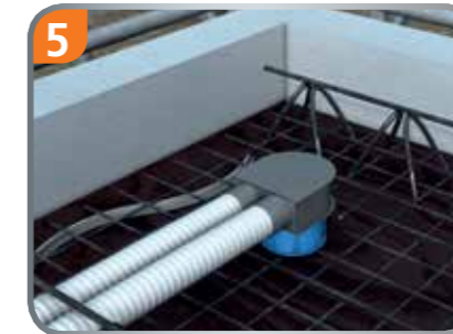
5. Rohre anschließen.
