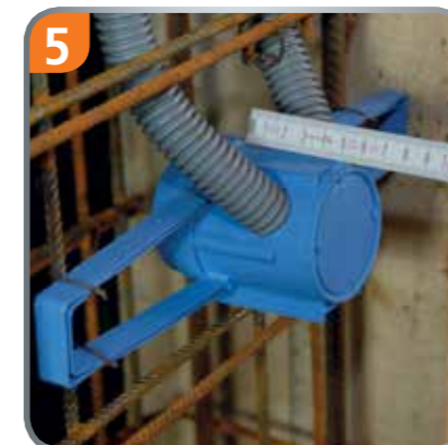
5 Die Montage der umgedrehten Flügelbetondose ermöglicht auch eine Betondeckung bis 60 mm.
