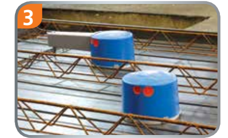
3. Variante: Einbaugehäuse kann vormontiert geliefert werden.
