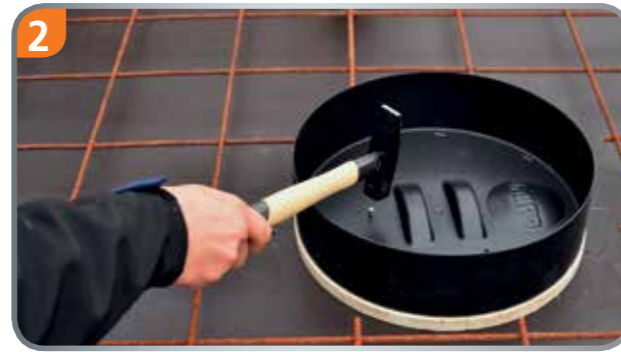
Bei Ortbeton auf Schalung nageln oder im Fertigteilwerk auf den Schaltisch kleben.
