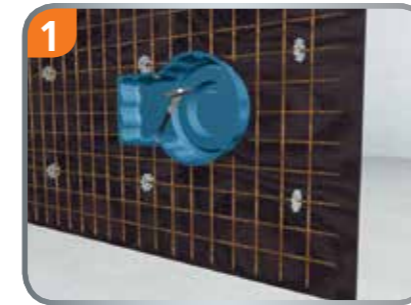
1 XXL Flexgroßdose mit Nägeln auf der Schalung befestigen.
