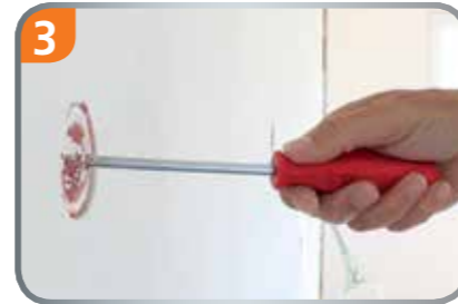
Zum Schluß mit einem Schraubenzieher den Putzdeckel entfernen.
