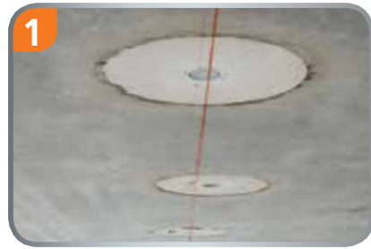
1 Linie anzeichnen, Ungenauigkeiten durch Ø 190 mm leicht korrigierbar.
