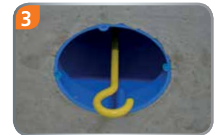
3 Deckenverbindungsdose mit Aufnahme für Leuchtenhaken. (Maximale Belastung 10 kg).
