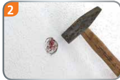
Mit dem Hammer leicht auf den Putzdeckel schlagen.
