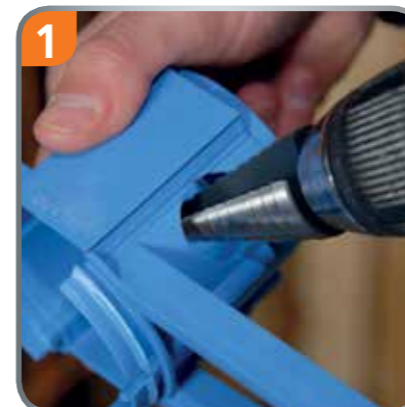
1 Rohrlöcher ausbohren.
