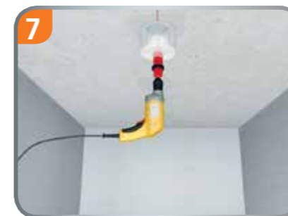
Mit einem Lochsneider wird die individuelle Öffnung ausgebohrt..
