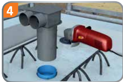
4. Stützen auf gewünschte Länge kürzen und in Hülse schieben.
