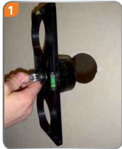
Bohren des mittleren Loches
