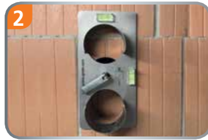
2 Bohrschablone einsetzen, ausrichten und weitere Löcher boren.
