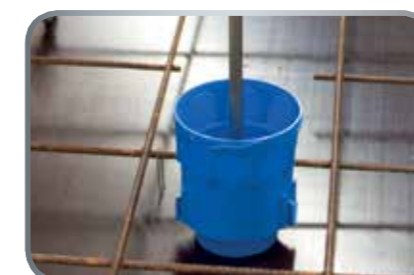
Gerätedeckel mit Nagler auf der Schalung befestigen
