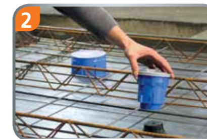
2. Variante: Mit Magnet auf Schaltisch positionieren.
