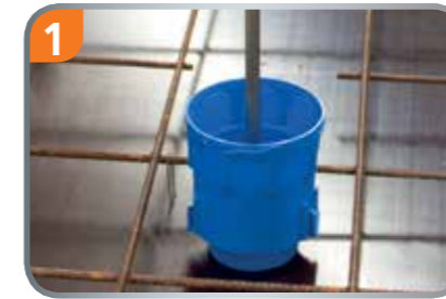
1 Universaldose mit Nägeln auf die Schalung fixieren.
