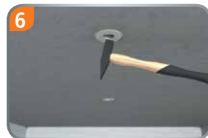
6 68 mm Deckel mit Hammer einschlagen.
