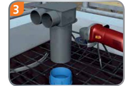
3. Deckenstützen auf die gewünschte Länge kürzen.
