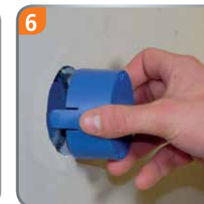
6 Aufstecken des Dosenoberteils.
