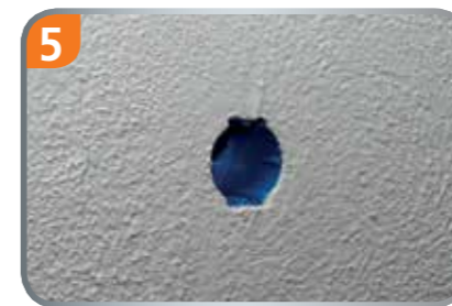
5 Wärmedämmung wird mit Gewebe verspachtelt und fertig verputzt.
