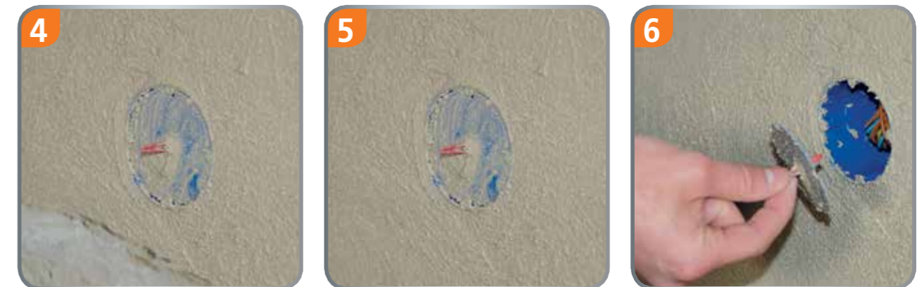
4 Der Putzer drückt das Dosenoberteil putzbündig. 5 Dose sitzt putzbündig nach VDE in der Wand. 6 Putzhaut entfernen – fertig!
