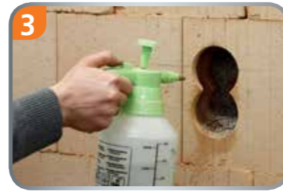
3 Bohrung anfeuchten.
