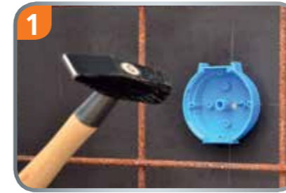
1 Gerätedeckel mit Nägeln auf der Schalung befestigen
