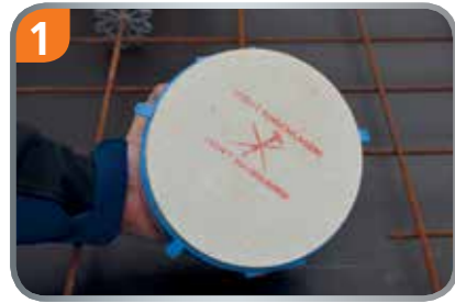
1 Mineralfaserplatte mit Piktogramm „Nicht einschlagen!“
