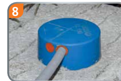
8 M20- oder M25-Rohr einschieben.
