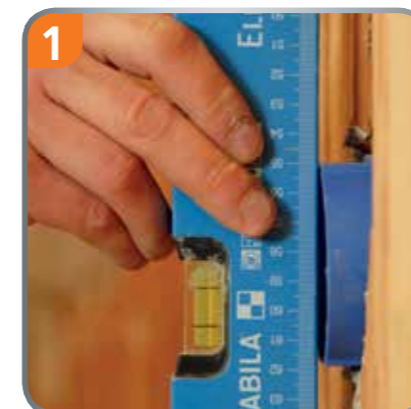
1 Dosenunterteil setzen, 1 cm vorstehen lassen.
