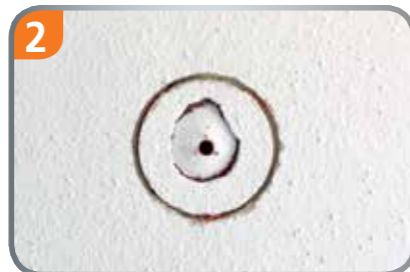
Eine saubere Kontur ohne Abbrüche entsteht.
