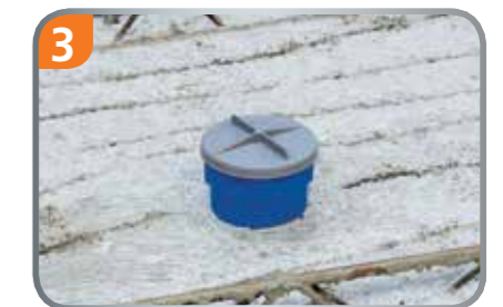
3 Betonfertigteil wird gegossen.
