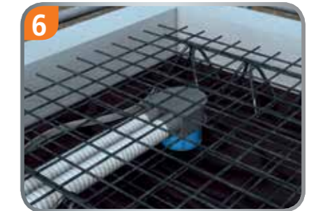
6. Obere Bewehrung einbringen und betonieren.
