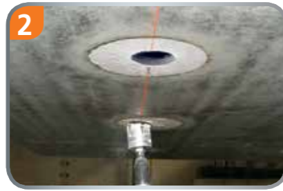
2 Individuelle Öffnungen können ausgebohrt werden.
