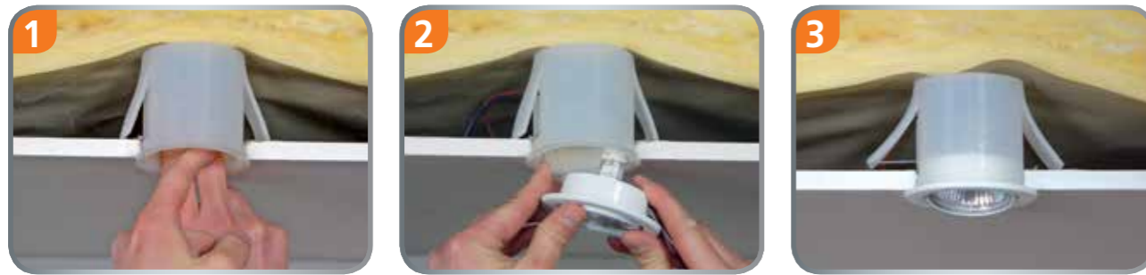
1 Schutzkappe in Bohrloch einschieben.
