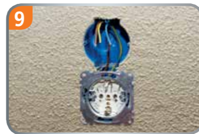
9 Zeit sparende Verdrahtung durch ausgebrochenen SCS-Steg.
