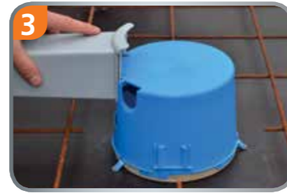
3 Trafotunnel einfach draufschieben.
