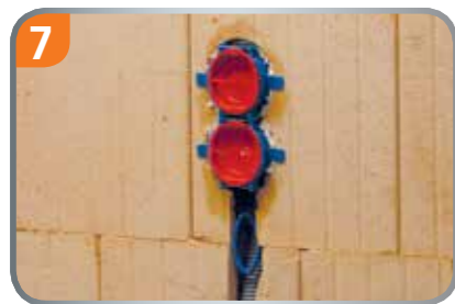
7 Rohr, Kabel einführen, Putzdeckel aufdrücken.
