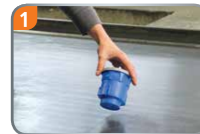
1. Variante: Mit Heißkleber auf Schaltisch kleben.
