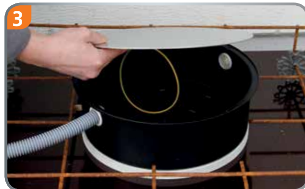
3 Rohre/Kabel einführen und stabile Blechplatte mit Kabelbinder befestigen.
