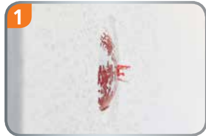
Nach dem Verputzen steht der Putzdeckel hervor.
