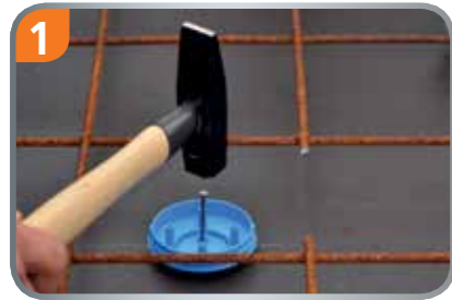
Leuchtauslassdose 35 mm aufnageln.
