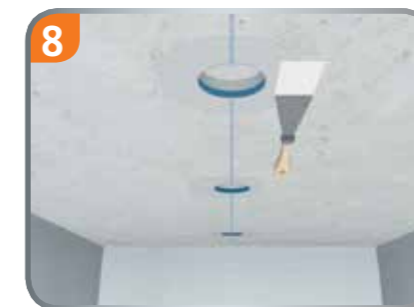
...und an die Mineralfaserplatte angespachtelt...
