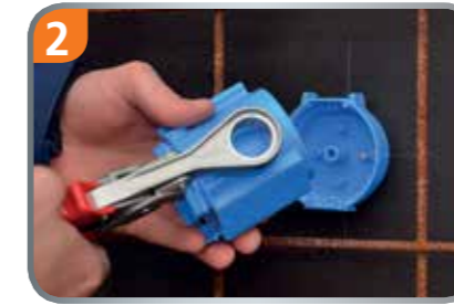
2 Rohr- oder Kabeleinführung mit der Stanzzange ausstanzen.
