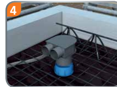
4. Stützen in die Lüftungshülse einstecken.
