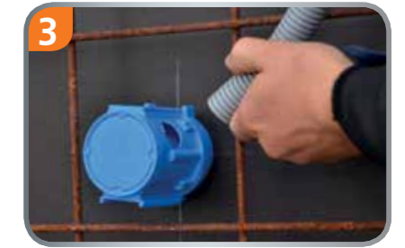
3 Rohr einführen.
