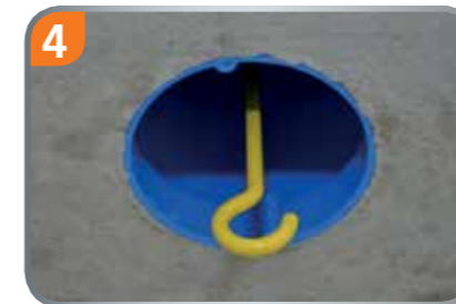
4 Montage mit Deckenhaken. (Maximale Belastung 10 kg).
