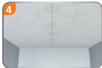
4 Fertigmontage: Fluchtlinie anzeichnen, Ungenauigkeiten können jetzt korrigiert werden.
