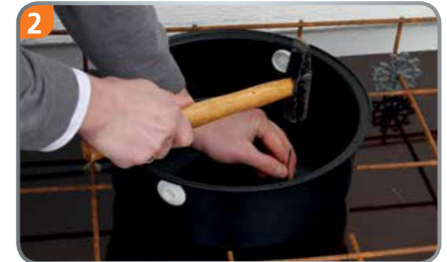
2 Bei Ortbeton auf Schalung nageln, im Fertigteilwerk auf Schaltisch kleben.
