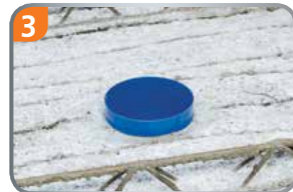
3. Betonfertigteil wird gegossen.
