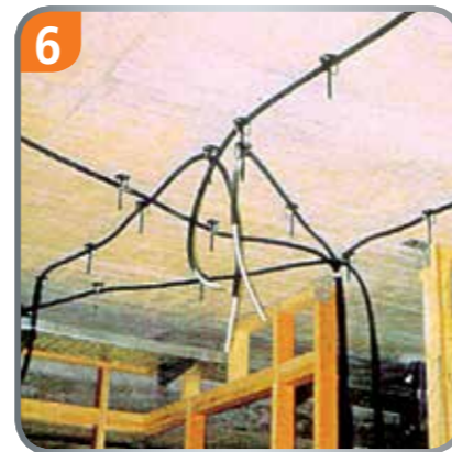
6 Auch als Sammelhalter in abgehängten Decken.
