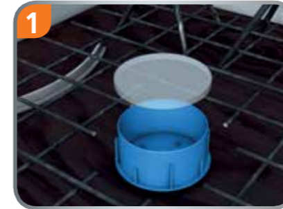
1. Schutzdeckeln von Lüftungshülse entfernen.
