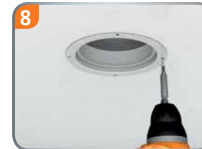
8. Adapterring von Luftauslass anschrauben.
