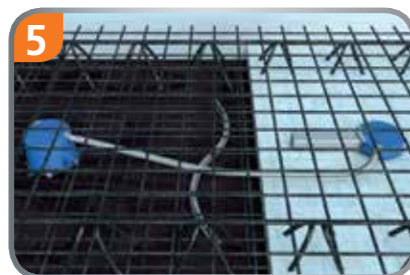
5 Stahlarmierung wird eingelegt und Beton gegossen.
