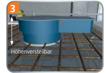
XXL Großdose auf den Deckel aufschieben von 140 - 200 mm.
