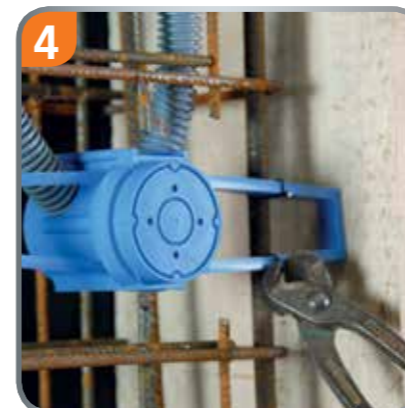
4 Einfach auf die Stahlarmierung binden. Betondeckung bis 40 mm.
