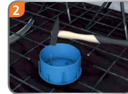
2. Lüftungshülse auf die Schalung nageln.
