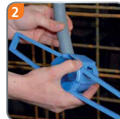
2 Rohre M20 oder M25 einführen.
