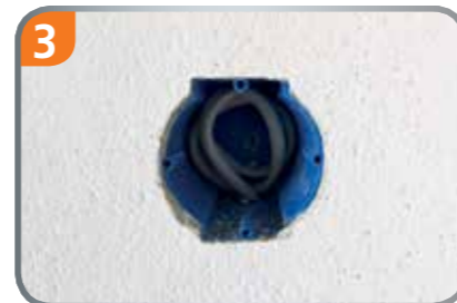
25 Sekunden für 5 Dosen ausbohren und Deckel entfernen (siehe Video).
