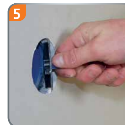
5 Bohrdeckel entfernen.
