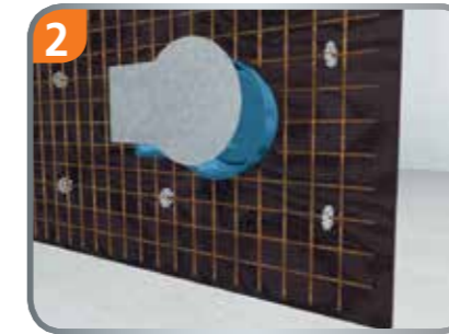
2 Deckel mit mitgelieferten Kabelbindern befestigen.
