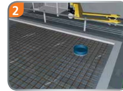
Stahlarmierung wird eingebracht.
