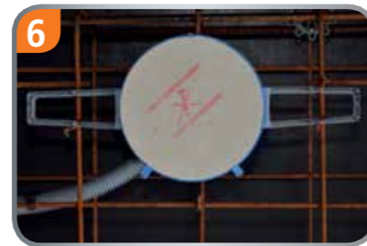
6 XL 170 ohne Trafotunnel, Montage mit Flügel.
