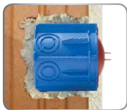
Mit Bohrkronen Ø 68 mm um den Putzdeckel fräsen.
