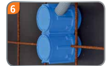
6 Bei Kombinationen feste Verbindung durch bewährte Schiebetechnik auf der ganzen Dosenlänge.
