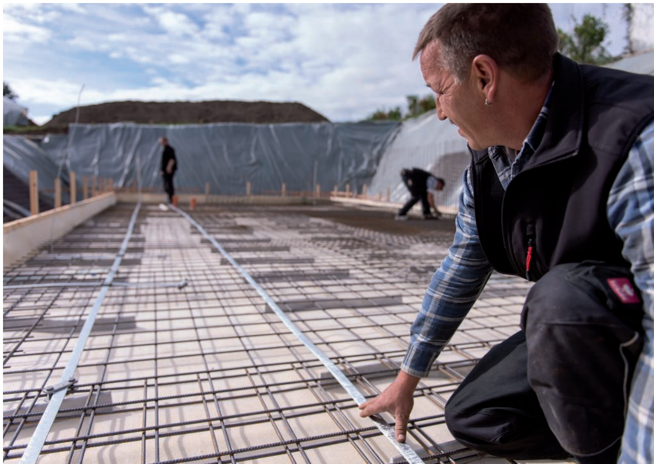
Verlegung eines Fundamenterders
