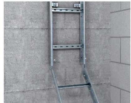
**Gelenkverbinding von Kabelleitern**
