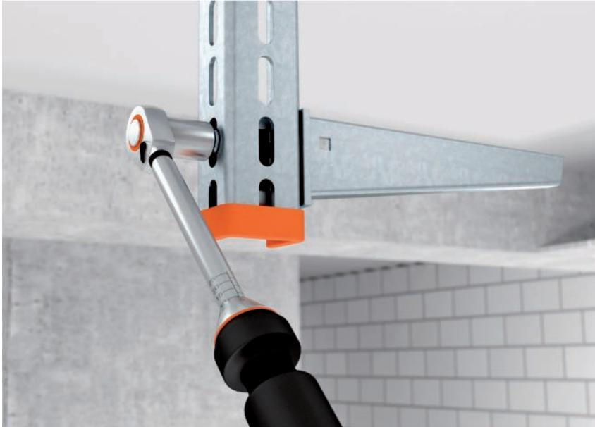
Bei der Montage eines Kabeltrag-Systems gelten unterschiedliche Anzugsmomente. Bitte beachten Sie, dass die angegebenen Drehmomente nur als grobe, unverbindliche Richtwerte dienen (siehe VDI 2230)!
