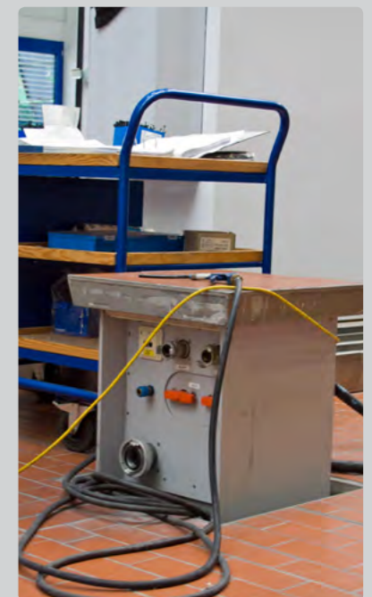
UNTERFLURVERTEILER
