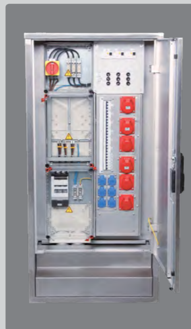
STANDVERTEILER IM EDELSTAHLGEHÄUSE
