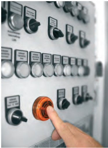
Durch leichtes Drücken mit der Hand kann das akustische Signal in Sekundenschnelle abgeschaltet werden
