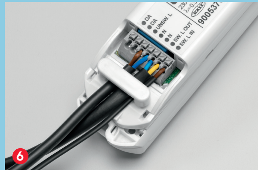
6 Schließen Sie die Netzleitung an den Notlicht-LED-Treiber an (Null-Leiter und ungeschaltete Phase) und fixieren Sie diese mit der Zulentlastung.
