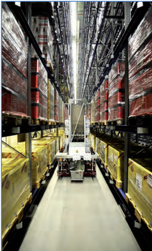
Optimale Ausleuchtung der Fluchtwege im Hochregallager
