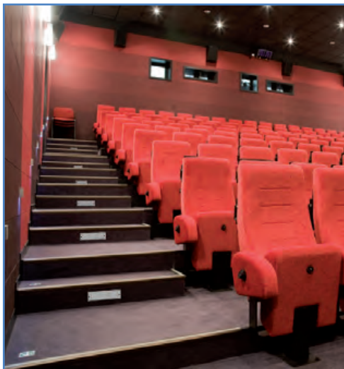
SL1 zur DIN-gerechten Ausleuchtung von Treppentufen
