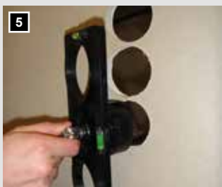
5 Einsetzen der Schablone.
