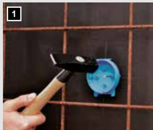
1 Gerätedeckel mit Nägeln auf der Schalung befestigen
