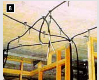
8 Auch als Sammelhalter in abgehängten Decken verwendbar. Ohne Bohren, einfach kleben und fertig.
