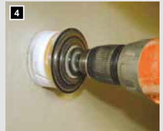
4 Ohne erneutes Messen der Montagestelle können Sie das Loch fräsen.
