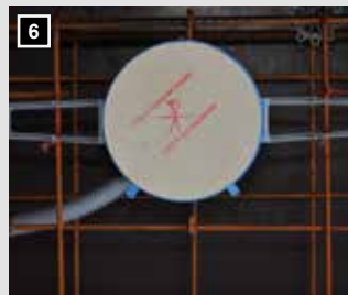
6 XL 170 ohne Trafotunnel, Montage mit Flügel.
