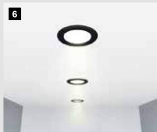
6 Jetzt können Downlights oder andere Einbaugeräte montiert werden.
