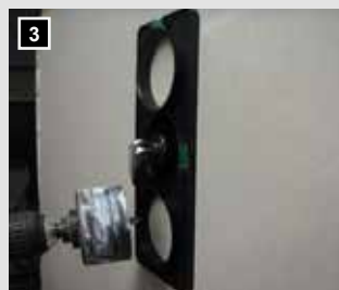
3 Anschließend durch die vorhandenen Locheinsätze bohren.
