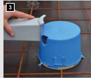
3 Trafotunnel einfach draufschieben.
