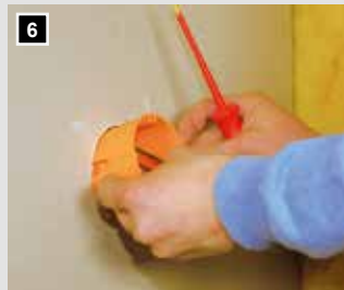
6 Ohne langes Suchen der Leitungen können Sie die Hohlwanddose montieren.
