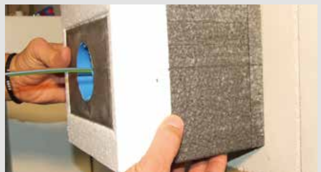
6. Element andrücken – Abbindung nach ca. 2 min.
