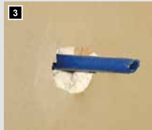
3 Der Trockenbauer schlägt mit dem Hammer ein Loch aus und läßt den Mitteldorn durchstehen, dieser dient als Zentrierung für die Bohrkronen.
