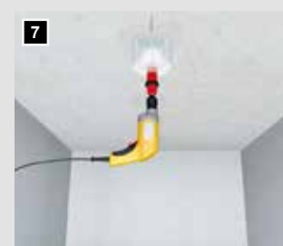
Mit einem Lochschneider wird die individuelle Öffnung ausgebohrt ...
