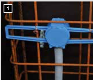
1 Rohr einführen und einfach auf die Stahlarmierung binden.
