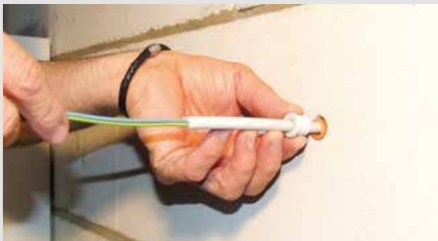
3. Installationsrohr mit Dichtstopfen winddicht verschließen (im Lieferumfang enthalten).
