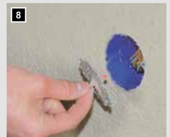
8 ... und Putzhaut entfernen – fertig!
