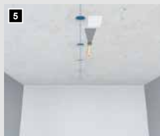
5 Mit einem Lochschneider wird die in- dividuelle Öffnung ausgebohrt und an die Mineralfaserplatte angespachtelt.
