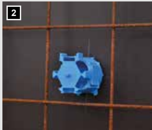
2 Dosenkörper auf Deckel aufdrücken.
