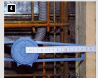
4 Die Flügel bis Dosenmitte (15 cm Länge) einfach an der Türschalung anstehen lassen.
