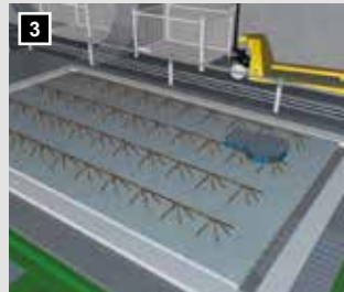
3 Betonfertigteil wird gegossen.
