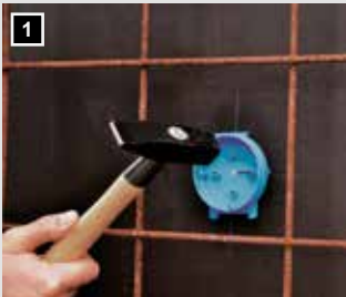
1 Gerätedeckel oder Leuchtenauslassdeckel mit Nägeln auf der Schalung befestigen.
