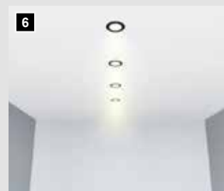
6 Jetzt können Strahler oder andere Einbaugeräte montiert werden.
