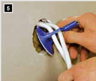
5 Leitungsträger und Leitungen aus der Wand ziehen.
