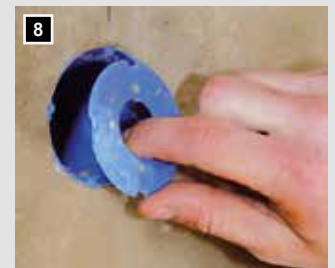
8 Dosendeckel rausnehmen – fertig!
