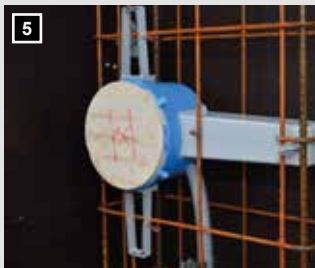
5 Montage mit Flügeln und Trafotunnel.
