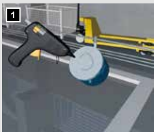
1 XL 170 Großdose mit Heißkleber auf den Schaltisch kleben.
