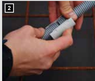
2 Klappmuffe schließen.
