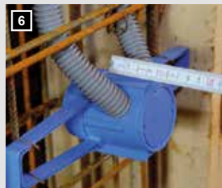
6 Die Montage der umgedrehten Flügelbetondose ermöglicht auch eine Betondeckung bis 60 mm.
