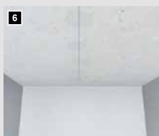
Fertigmontage: Fluchlinie anzeichnen, Ungenauig- keiten können jetzt korrigiert werden.
