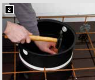
Bei Ortbeton auf Schalung nageln, im Fertigteilwerk auf Schaltisch kleben.
