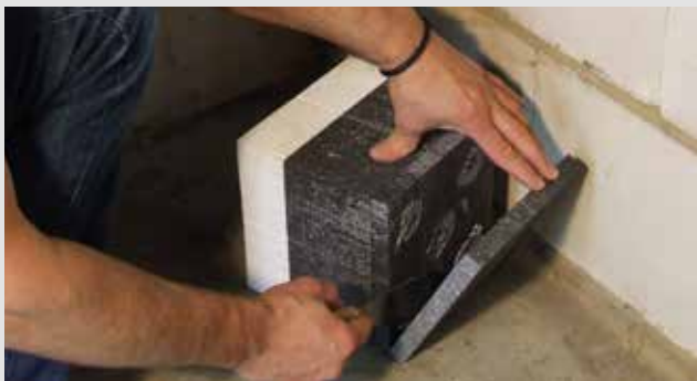
1. Dämmstärke anpassen, d. h. 20 mm Dämmplatten abtrennen.
