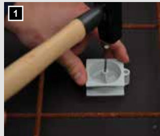
1 Unterteil auf die Schalung nageln.
