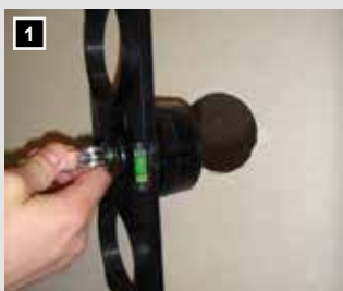
1 Bohren des mittleren Loches
