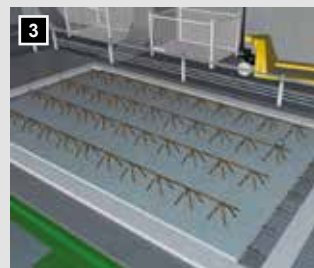
3 Betonfertigteil wird gegossen.
