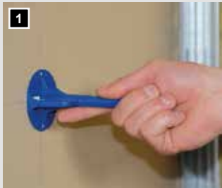
1 Aufkleben des Leitungsträgers an der Rückseite der ersten Beplankung.
