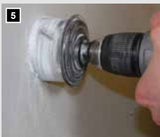
5 Ohne erneutes Messen der Montagestelle können Sie jetzt das Dosenloch fräsen.
