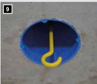
9 Montage als Deckendose, mit Klemmraum und Aufnahme für Deckenhaken.
