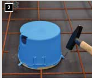
2 Bei Ortbeton auf Schalung nageln, im Fertigteilwerk auf Schaltisch kleben.
