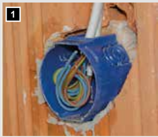
1 Dosenunterteil setzen ...
