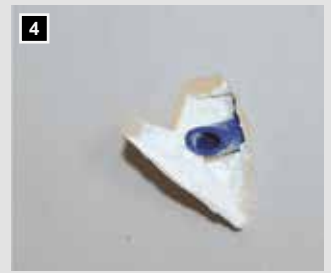
4 Der herausragende Mitteldorn dient als Zentrierung für die Ø 68 mm Bohrkronen.
