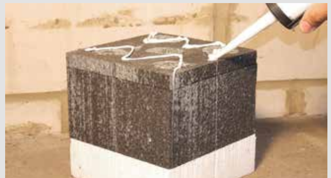
4. TIE-Hybridkleber raupenförmig dünn (5–6 mm) auftragen.
