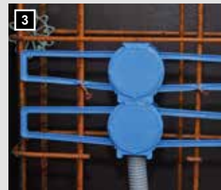
3 Bei Kombinationen feste Verbindung durch bewährte Schiebetechnik.
