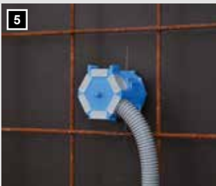
5 Fertig, absolut sichere Zugentlastung!
