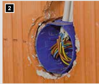
2 Einbringen der Elektrokabel oder -rohre.
