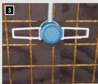
Montage mit Flügel auf der Stahl-armierung/Elektronikdose.
