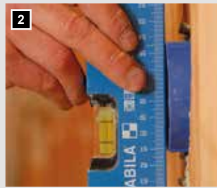
2 ... so dass es ca. 1 cm aus dem Mauerwerk steht.
