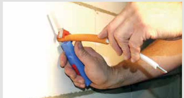
2. Installationsrohr wandbündig abschneiden.
