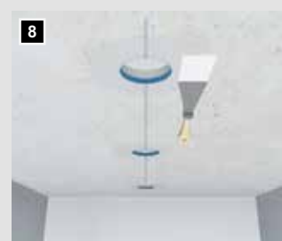
... und an die Mineralfaserplatte angespachtelt ...
