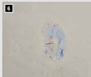
6 Mit der Putzfeder ist die Dose schnell gefunden.
