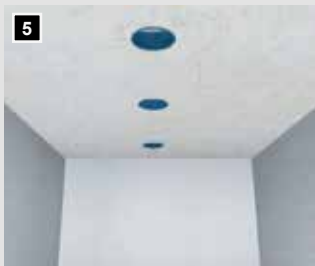
5 Fertig, keine Nacharbeiten nötig.
