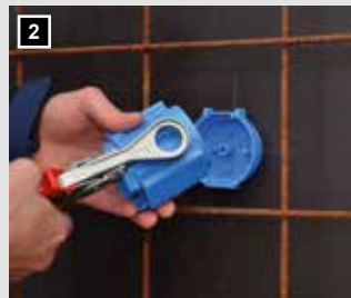
2 Rohr- oder Kabeleinführung mit der Stanzzange ausstanzen.
