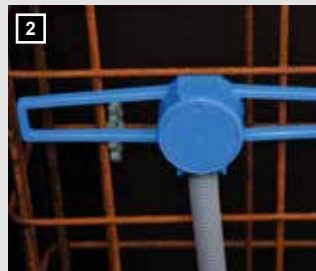
2 Für mehr als 20 mm Betondeckung die Dose einfach umdrehen.
