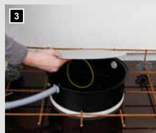
Rohre/Kabel einführen und stabile Blechplatte mit Kabelbinder befestigen.
