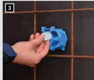
3 Nicht benötigte Öffnungen mit Schieber schließen.
