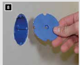
8 Dosendeckel entfernen – fertig.
