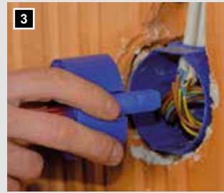
3 Dosendeckel ein- bis zweimal einrasten lassen.
