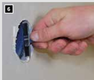
6 Leichtes Rausnehmen des durchfrästen Bohrdeckels.
