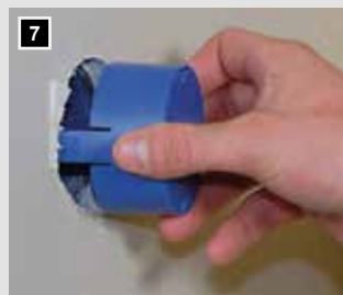
7 Aufstecken des Dosenoberteils und Einschieben bis zur Bündigkeit.
