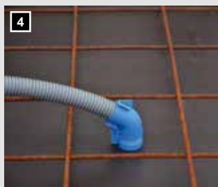
4 Auf das Unterteil stecken. Absolut sichere Zugentlastung!
