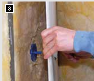
3 Der Trockenbauer schlägt mit dem Hammer ein Loch aus und lässt den Mitteldorn durchstehen, dieser dient als Zentrierung für die Bohrkronen.
