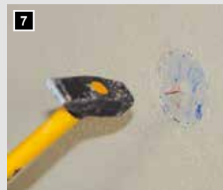
7 Einschlagen des Dosendeckels ...
