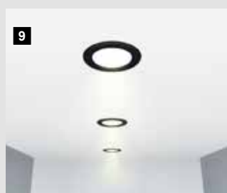
... jetzt können Downlights oder andere Einbaugeräte montiert werden.
