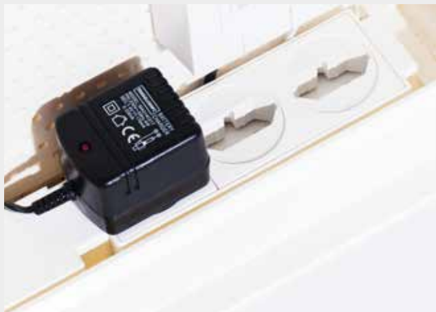
Auf den Kunststofftrageplatten werden die Hardware-Komponenten potentialfrei befestigt und über die 3-fach Steckdose für Euro-Stecker mit Netzspannung versorgt.
