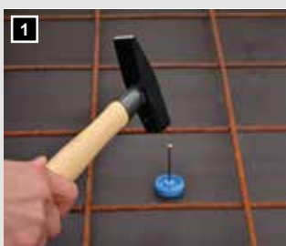
1 Unterteil auf die Schalung nageln.
