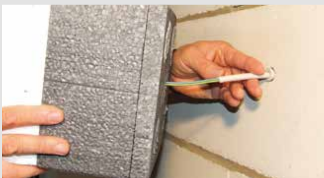
5. Leitung in die vorgebohrte Durchführung stecken.
