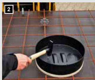
Bei Ortbeton auf Schalung nageln oder im Fertigteilwerk auf den Schaltisch kleben.
