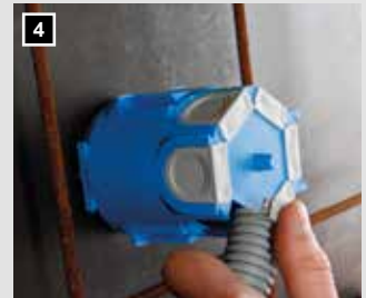
4 Rohr mit Quick-Fix-Schieber einschieben und schließen.
