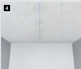
4 Fertigmontage: Fluchtlinie anzeichnen, Ungenauig- keiten können jetzt korrigiert werden.
