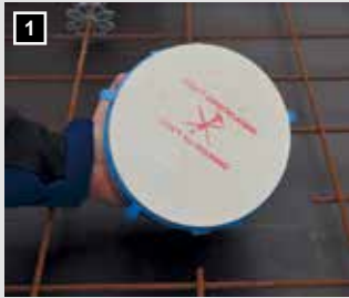
1 Mineralfaserplatte mit Piktogramm „Nicht einschlagen!“
