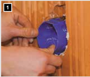
1 Dosenunterteil bündig mit dem Mauerwerk setzen.
