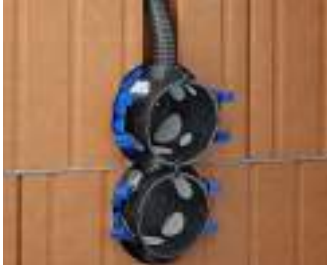
Dose mit aufgerastetem KLEMMFIX® einsetzen.
