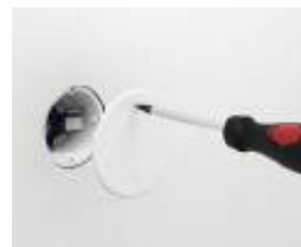
Mit Brandschutzdeckel (Art.-Nr. 1184-94) auch als Verbindungsdose verwendbar.
