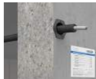
Wanddurchführung durch Brandschutzwand aus Beton.
