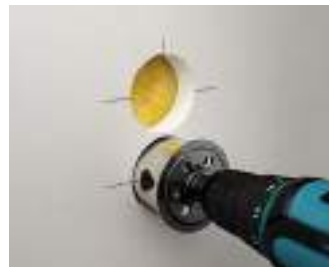
Einbauöffnungen Ø 68 mm mit KAISER-Fräser (z. B. PROFI Art.-Nr. 1081-10) mit Randversenk erstellen.
