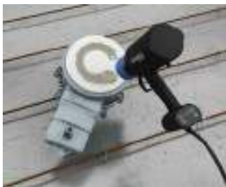
Montage des einteiligen Gehäuses mit Mineralfaserplatte...
