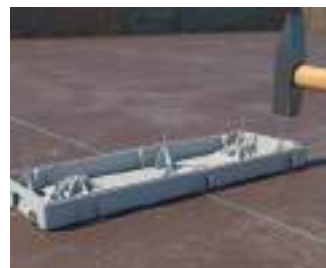
Befestigung mittels Stahlnägeln.
