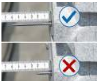
Die Dübel-Schraube muss das Grundelement um mind. 40 mm überragen.
