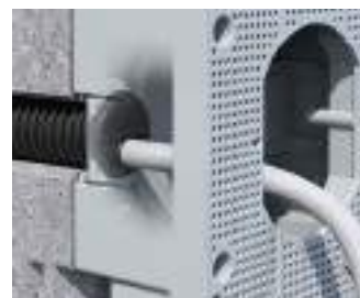
...und das Rohr mit einem Dichtstopfen versehen.
