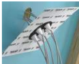
Bevor die Manschette aufgeklebt werden kann, muss sichergestellt werden, dass der Untergrund staubfrei ist. Anschließend Schutzfolie abziehen,...
