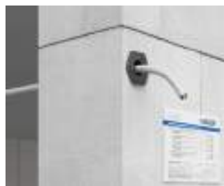
Wanddurchführung durch Brandschutzwand aus Kalksandstein.
