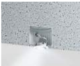
230V LED-Einbauleuchte mit 68 mm Einbaudurchmesser.
