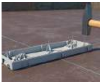
Befestigung mittels Stahlnägeln.
