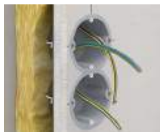
Einseitiger Einsatz der Strahlenschutzdose in einer 2-fach-Kombination.
