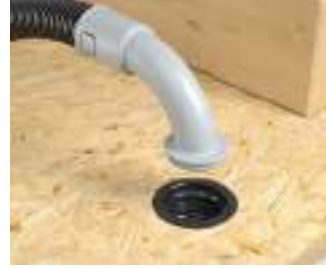
Aufstecken des 90°-Bogens auf das Elektroinstallationsrohr und...
