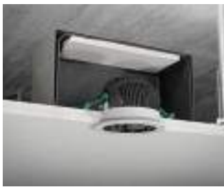
Brandschutzgehäuse für Einbauleuchten...
