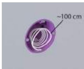
Glasfaserleitung zum Anschließen vorbereiten.
