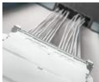
Der Zentral-Übergangskasten für das Auslassen mehrerer Leitungen, z. B. oberhalb einer in der Leichtbauwand sitzenden...
