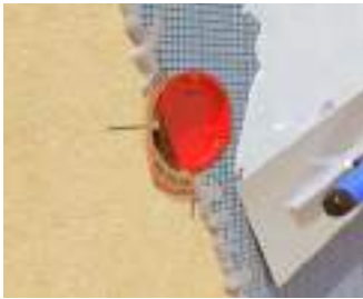
Vor dem Verputzen den Signaldeckel (Art.-Nr. 1181-60) einsetzen. Schützt das Doseninnere, die Schraubdomme und Schraubenköpfe.
