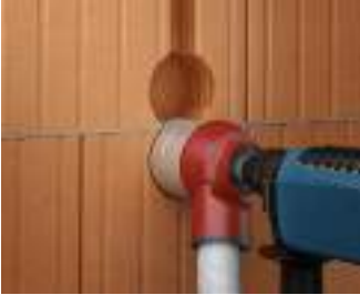
Einbauöffnung Ø 82 mm mit der Diamant-Schleifkrone (Art.-Nr. 1088-02) herstellen.
