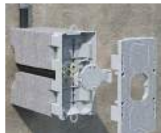
Gewünschtes Frontteil aufrasten. Styroporstopfen und die Dübelabdeckung aufbringen.
