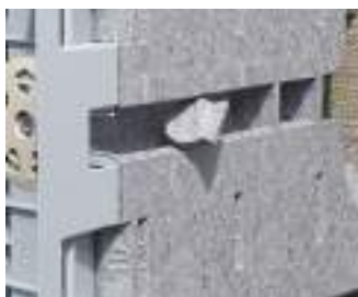
Für ein zusätzliches Rohr können die Stege bei den Neoporteilen entfernt...
