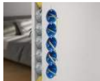
Die Schallschutzdose ist bis zu einer 5-fach-Kombination gegenüberliegend ohne Schwächung des Schallschutzes der Wand einsetzbar.
