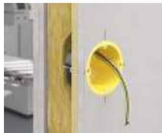
Einbau der Strahlenschutzdose in der Wand.
