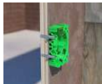
Befestigung mittels Gewindedübel.
