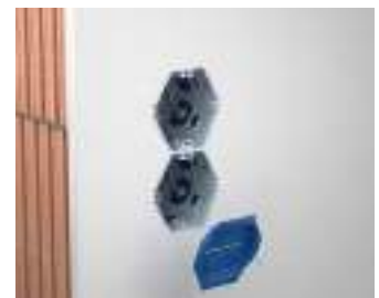
...sind die Dosen sauber geöffnet, der Signaldeckel kann mehrmals verwendet werden.
