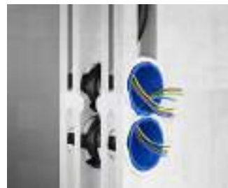
Gegenüberliegender Einsatz der Schallschutzdose.
