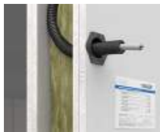
Wand Einführung M16 - M25 in Trockenbau-Brandschutzwand mit M25 Rohr.
