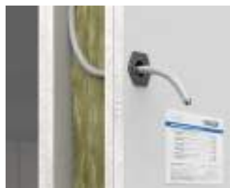
Für Wand Einführung und Wandauslass in Trockenbau-Brandschutzwand geeignet.
