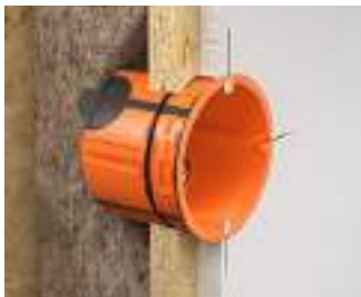
Wandaufbau OSB-Platte mit Gipskarton.
