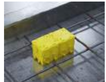
...befestigt auf der Stahlschalung mittels System-Haftmagnet.
