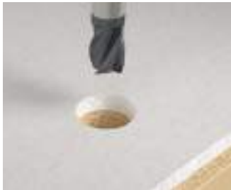
Maschinelles Erstellen der exakten Einbauöffnung von Ø 38 mm.
