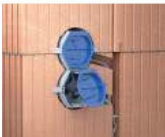
Signaldeckel (Art.-Nr. 1181-65) aufsetzen.
