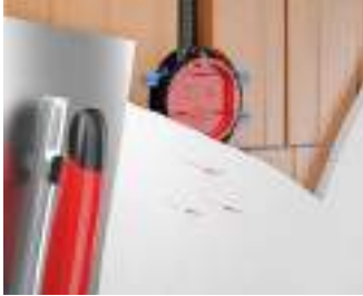
Durch das Eindringen des Putzes bis zum Lamellenring wird die Dose sicher und dauerhaft befestigt.
