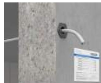
Wanddurchführung durch Brandschutzwand aus Beton.
