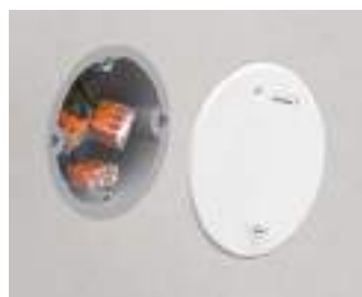
Einsatz der Strahlenschutzdose in der Wand.
