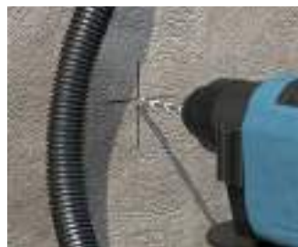
Bohrloch Ø 8 mm und mind. 50 mm tief erstellen.
