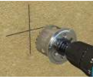
Erstellung der Einbauöffnung Ø 68 mm mittels geeignetem Fräser (z. B. Art.-Nr. 1082-30; Randsenker und Auswerfer-Feder sind zu demontieren).
