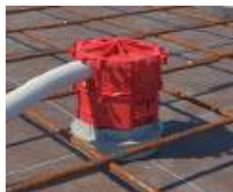
Universelle Anschraubfläche / Universal-Deckenauslass (Art.-Nr. 1265-13).
