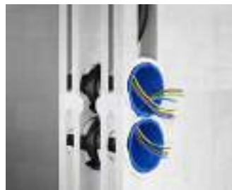
Gegenüberliegender Einsatz der Schallschutzdose.
