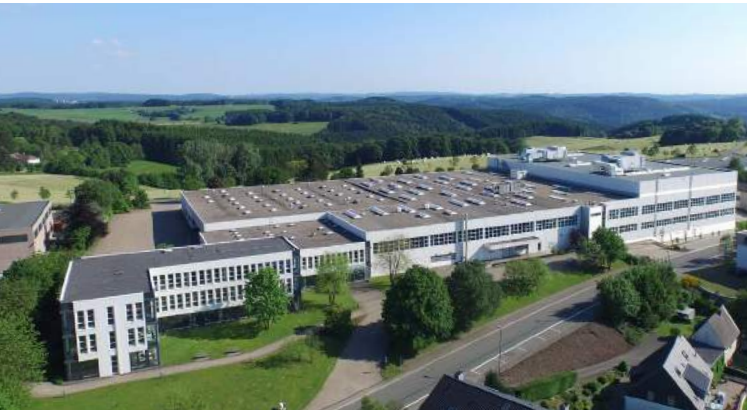
Hauptsitz KAISER Schalksmühle, Deutschland
