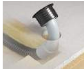
Nach Aufstecken des Wandanschlusselements wird der Wand- und Deckenübergang 90° durch die Einbauöffnung zurück in das Wandelement geführt...
