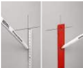
Mitte der oberen Einbauöffnung gemäß DIN 18015-3 sowie den Mittenabstand der weiteren Einbauöffnungen im 71 mm-Abstand anzeichnen.
