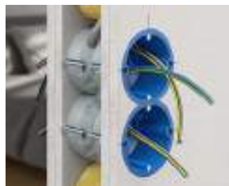
Gegenüberliegender Einsatz der Schallschutzdose.
