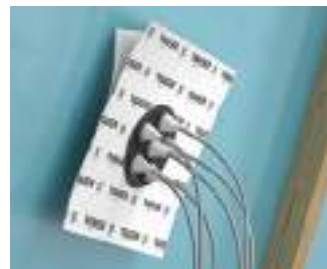
...Manschette aufkleben und gründlich von innen nach außen auf dem Untergrund feststreichen.
