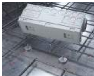
Befestigung mittels KAISER System-Haftmagnet (Art.-Nr. 1299-69) bzw. KAISER System-Haftmagnet PLUS (Art.-Nr. 1299-70).
