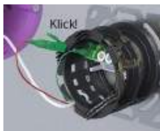
Pigtails in die Kupplung einstecken.
