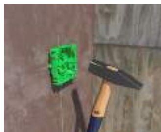
Befestigung mittels Stahlnägeln.
