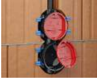
Signaldeckel (Art.-Nr. 1181-60) aufsetzen.
