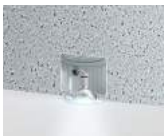
230V-Einbauleuchte mit 100 mm Einbaudurchmesser.
