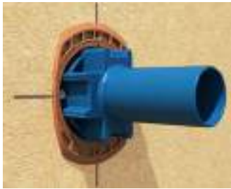
Das Setzwerkzeug (Art.-Nr. 1090-22) unter leichtem Druck bis zum Anschlag in die Dose führen. Schwenkschneiden müssen vollständig ausfahren.
