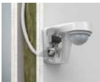
Sicherer Wandauslass bis F90 für den Anschluss von elektrischen Anbaugeräten...
