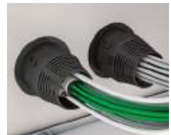
In einem Abstand von 50 mm ist eine waagerechte Anordnung möglich.
