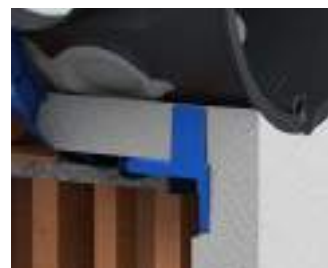
Der Putz dringt bis zum Lamellenring ein und sorgt so für die sichere und dauerhafte Befestigung der Dose.
