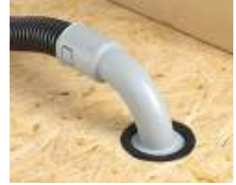
...Einrasten in das bereits montierte Wandanschlusselement.
