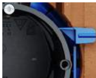
Tiefenanschlag zur Sicherstellung der Mindestputzstärke.
