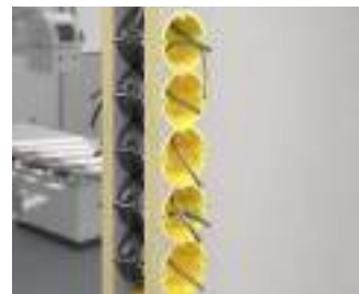
Einsatz der Strahlenschutzdose in einer 5-fach Kombination.
