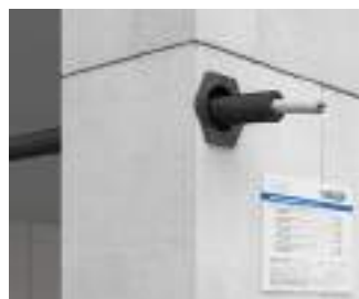
Wanddurchführung durch Brandschutzwand aus Kalksandstein.
