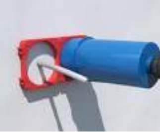
Einbauöffnungen mit den kombinierten Zentrierhilfen (Art.-Nr. 1090-68) im Normabstand 71 mm schneiden.
