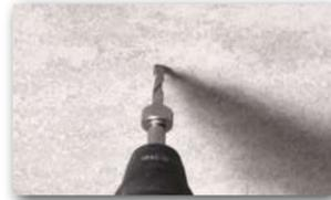
**1** Mit Bundbohrer definiertes Loch vorbohren.
