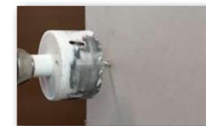
5 In vorgegebenes Loch auf der gegenüberliegenden Seite mit Zentrierbohrer der Fräskrone bohren; Dosenloch senken.
