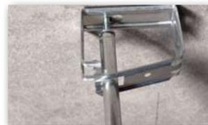
**4** Den Dübel in einem Arbeitsschritt mit Hilfe der Schlagfunktion einschlagen und so den Sammelhalter befestigen.
