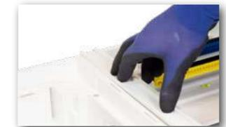
**6** Die verbundenen Verteiler als eine Einheit in die Wand einsetzen, Hohlwandanker anziehen und Abschlusschiene von vorne auf den Spalt klicken.
