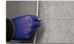
2 Das Produkt wird ohne Zusatzwerkzeug eingesteckt.
