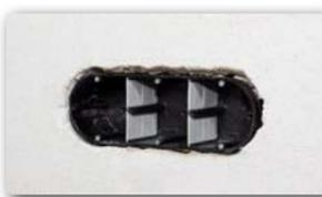
4 Dose in Wand einsetzen und mit Signaldeckeln (S. 41) schützen.
