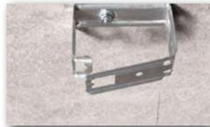
**5** Nach der Befestigung kann der Sammelhalter direkt mit Kabeln und Leitungen belegt werden.
