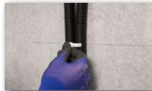
2 Das Produkt wird ohne Zusatzwerkzeug eingesteckt.
