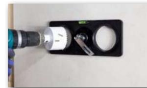
3 Anschließend durch die vorhandenen Locheinsätze bohren.
