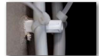
3 Kabel mit Kabelbinder an f-fix befestigen.
