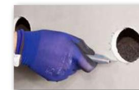
2 Mit Fräskrone Ø 68 mm die beiden äußeren Löcher senken und das Mittelstück mit Cutter oder Stichsäge ausschneiden.
