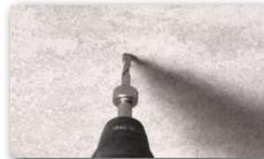
**1** Mit Bundbohrer definiertes Loch vorbohren.
