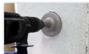
1 Mit Fräskrone die Wand vollständig durchbohren.
