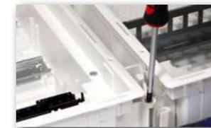
**4** Jeweils einen Hohlwandanker an den beiden Verbindungsstücken vormontieren.
