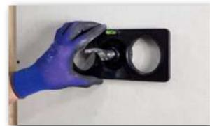
2 Präzises Ausrichten mit der integrierten Wasserwaage und Befestigen der Bohrschablone mit dem Spanner.
