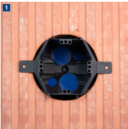
1 Einbauöffnung herstellen und die UI Schaumdose einsetzen.
