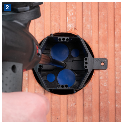
2 Die Schaumpistole am Dosenboden ansetzen und die Dose einschäumen.
