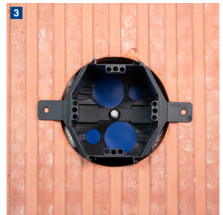
3 Die UI Schaumdose ist nun fertig installiert.
