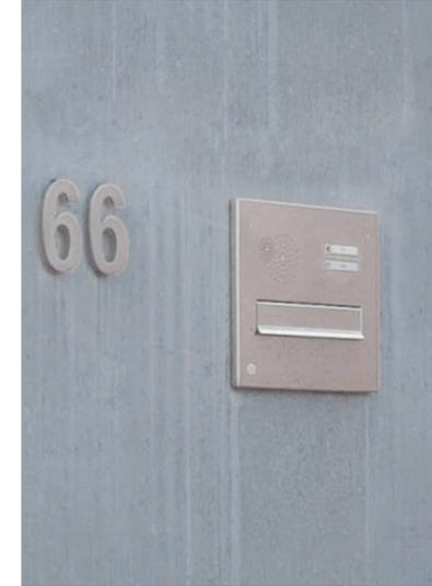
Bei der Mauerdurchwurf-Montage wird der Briefkasten in einen Mauerdurchbruch eingebaut.
