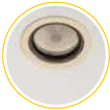
1. Alte Deckeneinbauleuchte mit größerem Deckenausschnitt.
