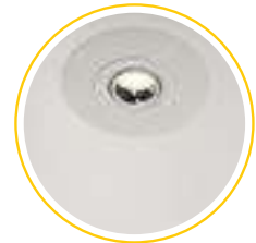
6. Neue Deckeneinbauleuchte in Reduzierring platziert.
