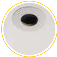
4. Reduzierring eingebaut. Größerer Deckenausschnitt gänzlich abgedeckt.
