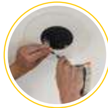
5. Elektrischer Anschluss und Installation der neuen Deckeneinbauleuchte.
