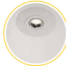
6. Neue Deckeneinbauleuchte in Reduzierring platziert.
