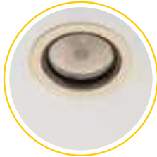
1. Alte Deckeneinbauleuchte mit größerem Deckenausschnitt.
