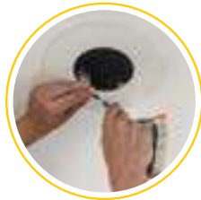
5. Elektrischer Anschluss und Installation der neuen Deckeneinbauleuchte.
