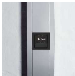
Steilvorlage: senkrecht montierter Edelstahlkanal mit KNX-Temperaturregler
