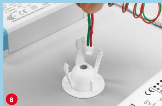
Installieren Sie die Status-LED in die Decke neben der Leuchte.
