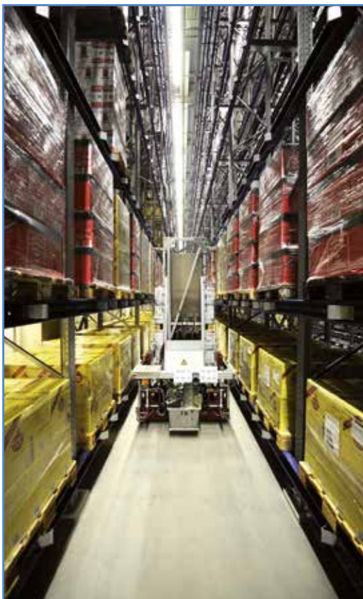
Optimale Ausleuchtung der Fluchtwege im Hochregallager
