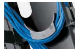
Die Überlängenaufnahme ist auf den Führungsringern zu montieren, um überschüssige Kabel zu managen.
