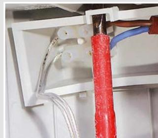
Mit einem Schraubendreher oder einer Spitzzange kann die Verschlusskappe auch nach dem Einbau herausgehoben werden, um das Betriebsgerät zu warten.
