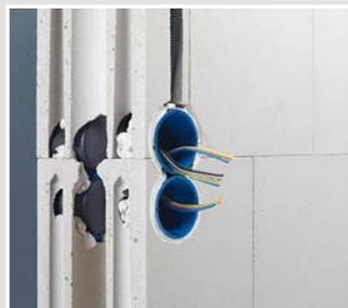
In die Schallschutzdose können Leitungen bis Ø 11,5 mm und Rohre bis M25 eingeführt werden.
