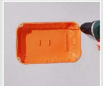
Eingesetzte Dose oder Kasten mit FX<sup>4</sup> Schnellverschraubung fixieren.
