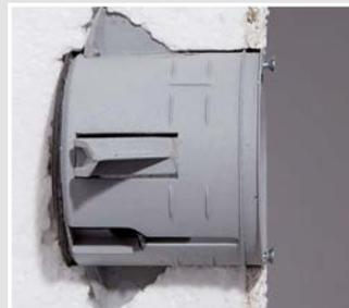
Die hintere Dichtlippe bewirkt eine Abdichtung zum Dämmstoff und vermeidet Zugluft entlang der Dose.
