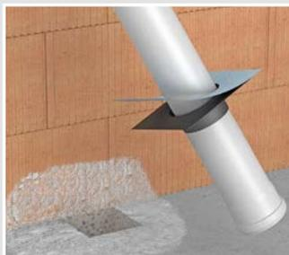
Manschette über Leitung/Rohr ziehen und die Schutzfolie abziehen.
