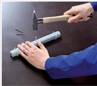
Deckenleiste auf der Schalung positionieren und mit Nägeln befestigen.
