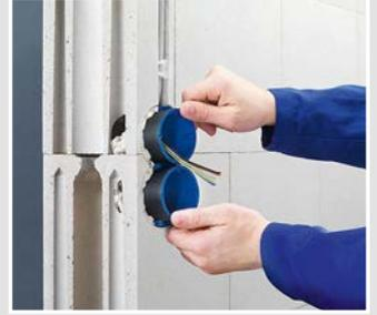
Die Fixierung der Schallschutz-dosen erfolgt einfach mit Gips.
