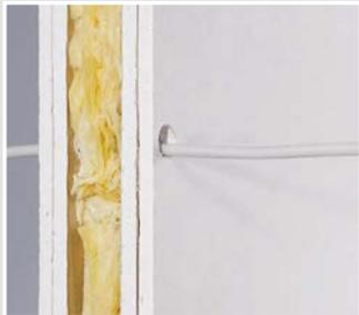
Installationsöffnung  $\varnothing$  20 mm mit einem Fräser (z. B. KAISER Hartmetallfräser Art.-Nr. 1088-06) oder einem Bohrer erstellen.
