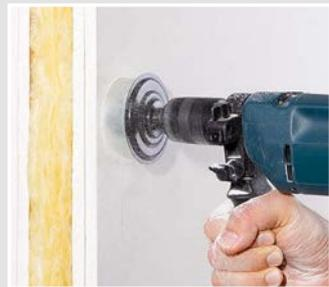
Mit einem Fräser (z. B. MULTI 4000: Art.-Nr. 1084-10) wird eine Ø 74 mm Öffnung erstellt.
