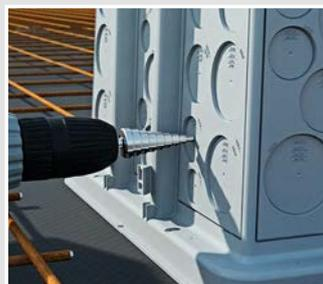
Die Rohreinführungen lassen sich mittels Stufenbohrer oder Hammer und Schraubendreher einfach öffnen.
