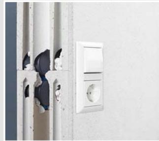
Der Schallschutz wird im gegenüberliegenden Einbau bis zu einer 5-fach-Kombination gewährleistet.
