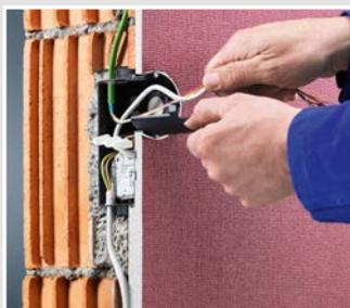
Durch Einsetzen der Trennwand lassen sich zwei unterschiedliche Spannungsarten normgerecht in der Electronic-Dose unterbringen. Darüber hinaus bietet sie einen großzügigen Installationsraum...
