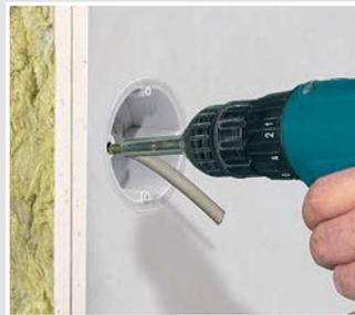
Befestigung der Dosen in bewährter Hohlwandtechnik mit der KAISER FX4-Technik.
