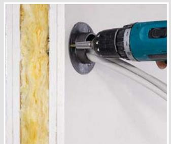
Befestigung, wie bei Hohlwanddosen, durch das Anziehen der Laschenschrauben.
