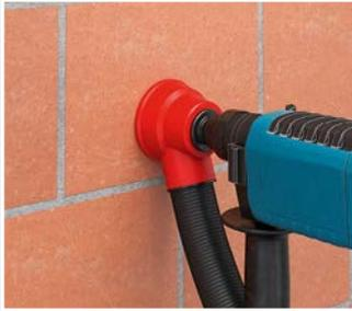
Mit einer Schleifkrone (z. B. Art.-Nr. 1088-02) wird eine Ø 82 mm Einbauöffnung erstellt.
