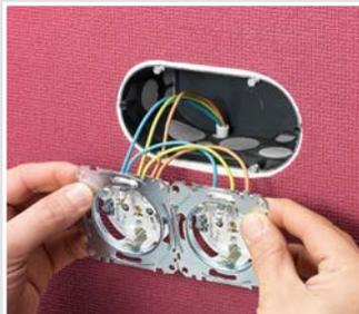
Die Doppel-Geräte-Verbindungs-dose ermöglicht aufgrund der großen Einbauöffnung ohne Mittelsteg...
