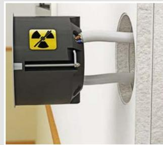
Führen Sie die Leitungen ein, anschließend setzen Sie die Dose in die Einbauöffnung.
