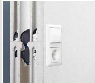
Einbaubeispiel einer Schalter-Steckdosenkombination.
