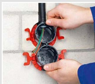
Dose mit aufgerastetem KLEMMFIX® einsetzen.
