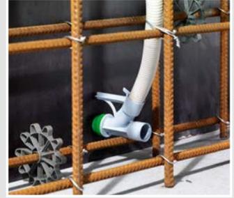
Die umlaufende Rohrsicherung hält das Rohr fest in der Aufnahme und sichert somit ein funktionierendes Leerrohrsystem.
