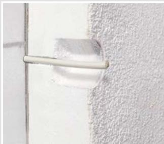
Die Öffnung ist nur so tief wie nötig. Die Dämmung bleibt erhalten und die Leitung unbeschädigt.
