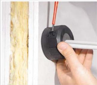
Das Dichtelement durch eine 1/4-Linksdrehung lösen und öffnen.
