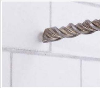
Installationsöffnung mit einem Ø 32 mm Bohrer erstellen.
