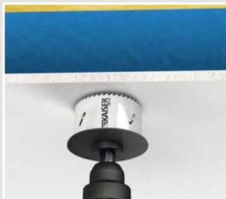
Erstellung der Fräsöffnung (z. B. mit dem Turbofräser MULTI 4000 – Art.-Nr. 1084-10).
