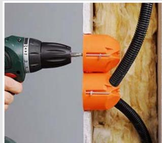
Beide Laschenschrauben der FX<sup>4</sup> Schnellverschraubung anziehen.
