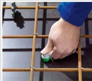
Die neue Rastverbindung bietet eine sichere Verbindung zwischen Frontteil und Rückteil.
