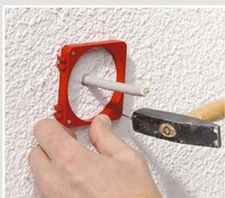
Mit dem Hartmetallfräser 180 bohren Sie 68 mm-Installationssöffnungen bei vorhandener Leitung.
