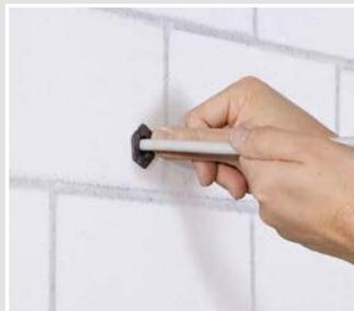
Leitungsschott System LS 90 seitlich öffnen, um die Leitung fügen und in die Öffnung drücken.
