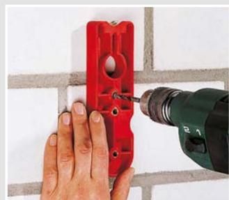
Vorbohren. Für Mehrfach-dosen mit Bohrschablone Zentrierbohrung im Kombinationsabstand herstellen.
