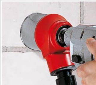
Passgenaue Wandöffnung (Ø 82 bis 84 mm) mit Diamant-Schleifkrone erstellen.
