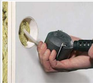
Die passgenaue Öffnung für die Leitung wird mit dem KAISER Universal-Öffnungsschneider Art.-Nr. 1085-80 rauchdicht hergestellt. Den Öffnungsschneider für 3 x 1,5<sup>2</sup> auf Ø 8,5 einstellen, für 5 x 1,5<sup>2</sup> auf Ø 9,5 einstellen, für 3 x 2,5<sup>2</sup> auf Ø 9,5 einstellen.
