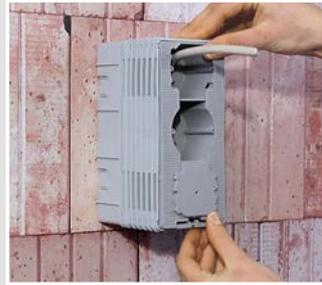
Den Kombinationseinsatz aufsetzen (Verschlussclip unten) und einrasten.
