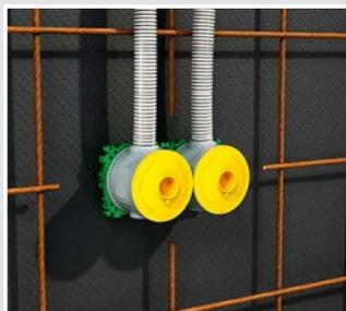
Rückteil mit Rohr bzw. Kabel auf das Frontteil rasten, anschließend betonieren.
