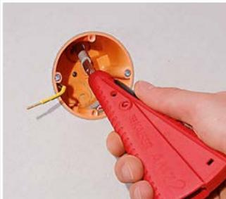
Mantel und Schirm der Leitung mit AMZ 2 Art.-Nr. 1190-02 entfernen. Blanken Beidraht mit transparentem Isolierschlauch versehen.
