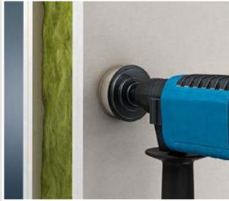
Einbauöffnung Ø 68 mm mit Turbofräser MULTI 4000 (Art.-Nr. 1083-10) erstellen.
