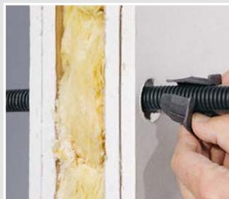
Für die Montage das Schott seitlich öffnen und über das Rohr schieben.
