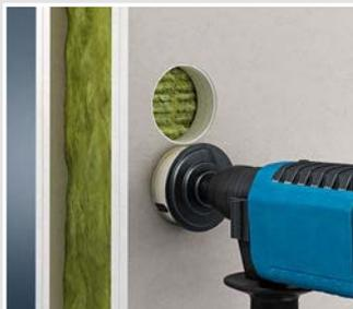
Für Kombinationen Einbauöffnungen Ø 68 mm im Mittenabstand 71 mm erstellen.
