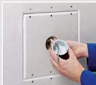
Installationsöffnung von Ø 74 mm erstellen und Hohlwanddose HWD 90 einsetzen.
