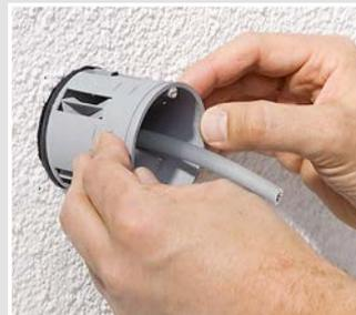
Die Geräte-Verbindungsdose ECON® Styro55 einfach in die Einbauöffnung einsetzen.
