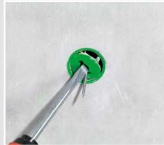
Nach dem Ausschalen lässt sich die Putzhaut einfach und schnell mit einem Schraubendreher öffnen.
