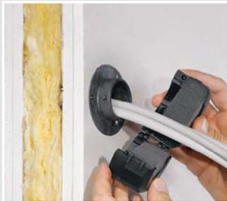
Dichtelement aufklappen und entfernen.
