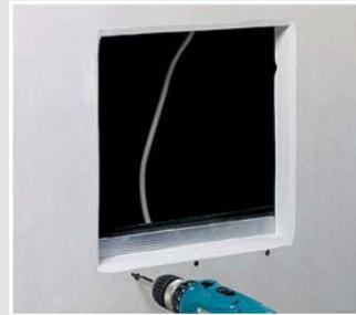
CW-Profil einfügen und mittels Schnellbauschrauben durch die Beplankung befestigen.
