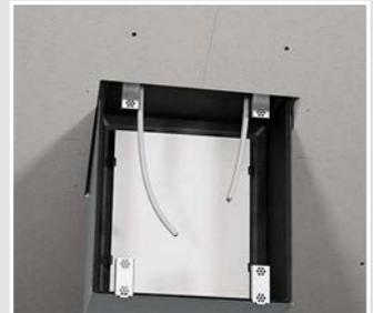
Das Gehäuse in die Bauteilöffnung führen und ausrichten.
