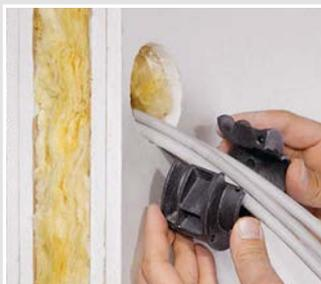
Den zweiteiligen Schottzylinder um die Leitungen legen und zusammendrücken.
