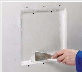
Mit Spachtel glatt streichen, um das wandbündige Einsetzen der zweiten Beplankung zu ermöglichen.
