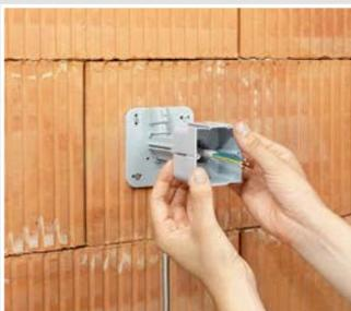
Gerätedose bis zum Anschlag auf den Trägerarm aufsetzen.
