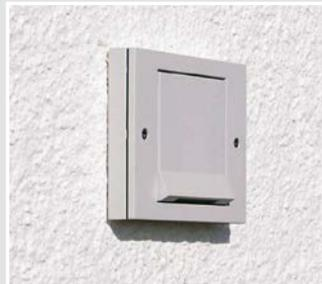
Geräteeinbau ohne Zerstörung der Dämmung und ohne Wärmebrücken.
