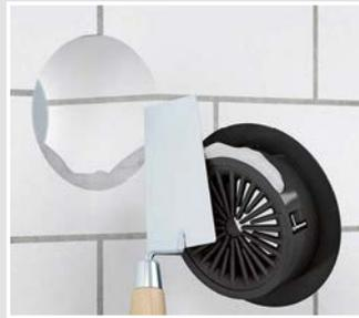
Schottzylinder mit Gips, Mörtel oder Schnellzement in die Installationsöffnung eindrücken und die Leitungen oder Rohre durchführen.
