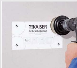
Beiliegende Bohrschablone auf die Wand kleben. Vier Ecken mit Fräser öffnen. Kanten mit Cutter oder Stichsäge ausschneiden.
