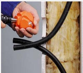
Bei Hohlwanddosen (außer ECON® = werkzeuglos) mit dem Öffnungsschneider alle erforderlichen Einführungen herstellen.
