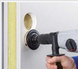
Zwei Einbauöffnungen mit Turbofräser MULTI 4000 Ø 68 mm (Art.-Nr. 1083-10) im Mittenabstand von 71 mm fräsen.
