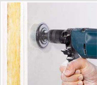
Installationsöffnung mit einem  $\varnothing$  74 mm Fräser (z.B. MULTI 4000: Art.-Nr. 1084-10) erstellen.
