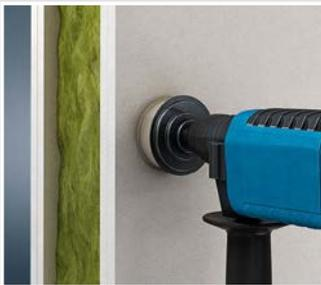
Einbauöffnung mit Turbofräser MULTI 4000 Ø 74 mm Art.-Nr. 1084-10 fräsen.
