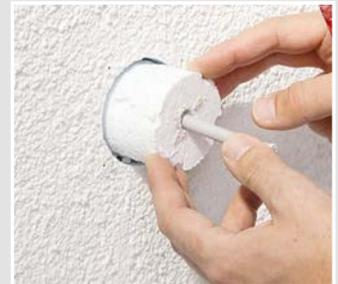
Den Bohrkern aus der Öffnung entfernen.
