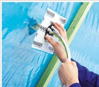
Die werkzeuglose Leitungs- oder Rohrdurchführung der ECON®-Technik bietet maximalen Installationskomfort und ermöglicht eine schnelle Verarbeitung.
