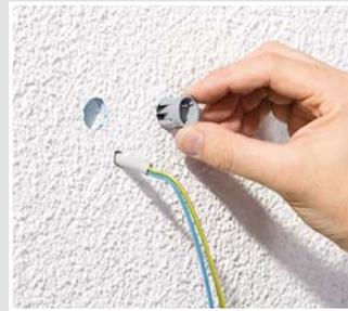
Die Ankerhülse des Mini-Geräteträgers wandbündig in die Einbauöffnung eindrücken.
