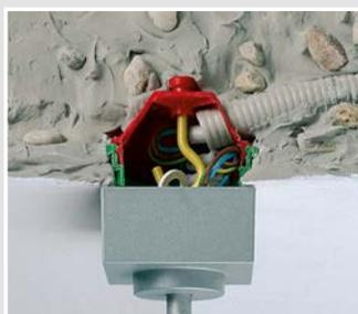
Deckendose 45° mit Leuchtenhaken zur Befestigung einer Pendelleuchte.
