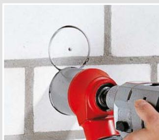
Diamant-Schleifkrone aufsetzen und Löcher im Ø 68 mm oder Ø 82 mm diamantschleifen.
