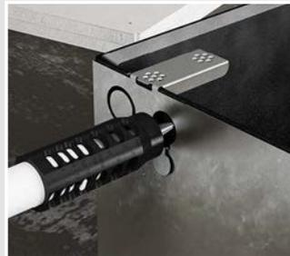
Leitungs- und Rohreinführungen öffnen und mit Universalöffnungsschneider (Art.-Nr. 1085-80) passende Einführungen erstellen.
