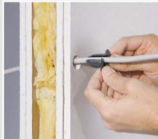
Für die Montage das Schott seitlich öffnen und über die Leitung schieben.
