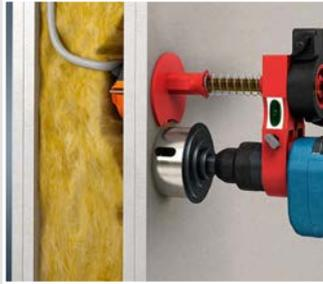
Einbauöffnung Ø 68 mm erstellen; im Bestand Mittenabstand 71 mm mit Hilfe des Profix.
