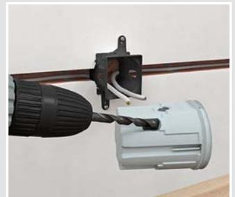
Passgenaue und luftdichte Leitungseinführung mit Bohrer erstellen.
