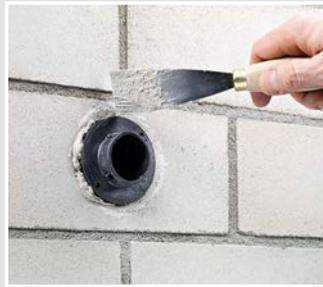
Schottzylinder mit Gips, Mörtel oder Schnellzement in die Installationsöffnung eindrücken und die Leitung durchführen.
