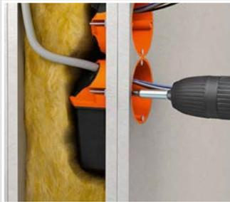
Laschenschrauben der Dose anziehen und den Tunnel ausklappen.
