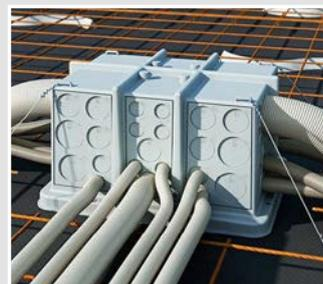
Zusätzliche Laschen ermöglichen eine sichere Fixierung mit Rödeldraht an der Bewehrung.
