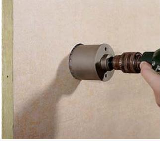
In einer Blechbeplankung wird die Installationsöffnung mit dem Fräser (Art.-Nr. 1083-74) hergestellt.
