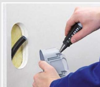
Ebenso bietet sie 6 Möglichkeiten der Leitungseinführung bis zu einem Ø von 11,5 mm.
