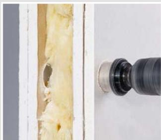
Installationsöffnung  $\varnothing$  35 mm z. B. mit dem KAISER Fräser MULTI 4000 (Art.-Nr. 1082-10) erstellen.
