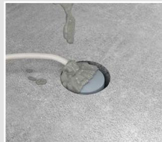
...der freie Raum wird mit Beton aufgefüllt und verdichtet. Das Auslaufen von Beton an der Unterseite verhindert ein untergesetztes Schalbrett.
