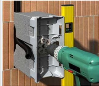
Geräteträger an die Wand halten, ausrichten und mit Dübel befestigen.
