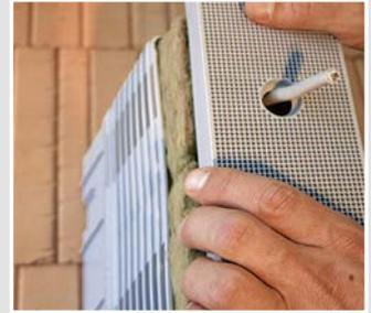
Montageplatte aufsetzen (Verschlussclip unten) und verschließen.
