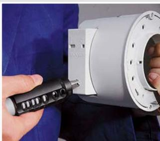
Die Öffnung für die Leitungseinführung wird passgenau und luftdicht in der Verschlusskappe mit dem Universal-Öffnungsschneider erstellt.
