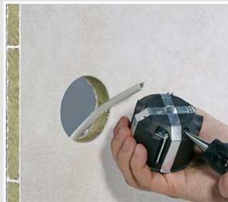
Die Belegung kann für max. vier Einführungen bis Ø 13 mm sowie für schwer entflammable Leitungen gemäß UL-V0 erfolgen. Die Öffnung für die Leitungseinführung erfolgt mit dem KAISER-Universal-Öffnungsschneider.
