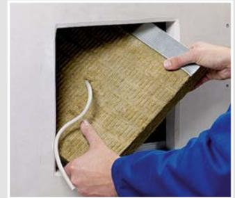
Zuschnitt der zu hinterlegenden Mineralwolle mit oberem CW-Profil in den Schacht einführen.
