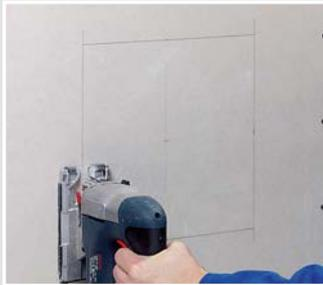
Erstellen Sie einen Ausschnitt von 300x300 bis 300x600 mm (siehe oben). Das Zuschnittsmaß der zu hinterlegenden Mineralwolle muss umlaufend mind. 25 mm größer sein.
