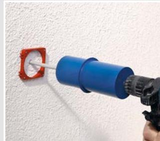
Mit dem Hartmetall-Fräser 180 Art.-Nr. 1088-07 die Einbauöffnung passgenau bis zum Tiefenanschlag schneiden.
