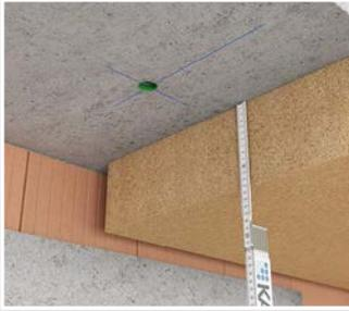
Decke mit Rohr- oder Leitungsauslass. Ausmessen der Dämmstärke.
