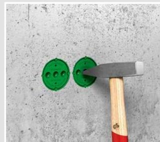
Betonbaudosen oder -kästen öffnen, anschließend Geräte oder Deckel montieren.
