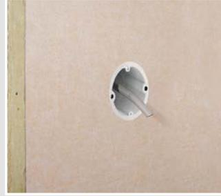
Hohlwanddose HWD B15 mit Laschenschrauben FX4 in der Wand montieren.
