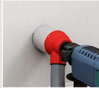
Bei Dämmstärken < 100 mm Wandöffnung erstellen (Ø 82 mm).
