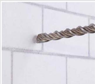
Installationsöffnung mit einem  $\varnothing$  20 mm Bohrer erstellen.
