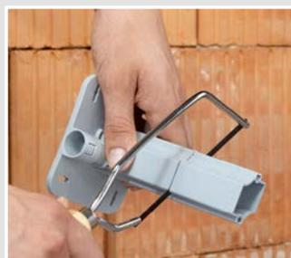
Träger durch Absägen auf benötigte Länge kürzen, integrierte Maßangabe sorgt für exaktes Ablesen des Maßes.
