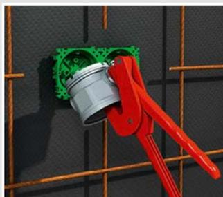
Rohr- oder Kabeleinführung herstellen (Stanzzange oder Öffnungsschneider).
