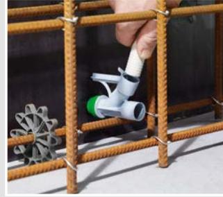
Nun wird das Leerrohr bis zum Anschlag in die Aufnahme des Krümmers eingebracht.
