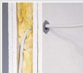
Wand-einführung in Trockenbau-Brandschutzwand.
