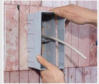
Aufstockelement aufsetzen und einrasten.
