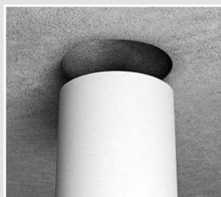
Nach dem Entschalen den Schalungskörper rückstandslos aus der Bauteilöffnung entfernen.
