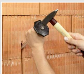
Leitungswege vorbereiten. Eine direkte Leitungsführung durch Mauerwerk und Dämmung sollte vermieden werden.
