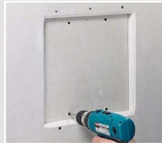
Beplankungsausschnitt (gem. Abb. 1) einfügen und am CW-Profil befestigen.
