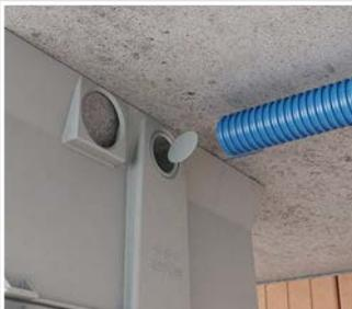
Rohr oder Leitung in das Einbaugehäuse einführen; Rohr mit Dichtstopfen versehen.
