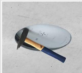
Nach dem Entschalen das Frontteil mit einem Hammerschlag öffnen (z. B. Art.-Nr. 1282-65).
