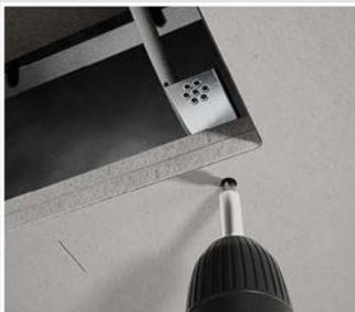
Gehäuse mit Schnellbauschrauben an der Brandschutzdecke befestigen...
