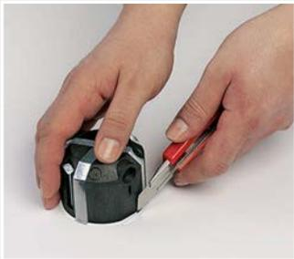
Die Kombination von Geräte-Verbindungs-dosen ist ganz einfach möglich. Nach Erstellung der Fräslöcher (Ø 74 mm) im Normabstand (71 mm) ist der markierte Bereich des Halterandes abzutrennen.
