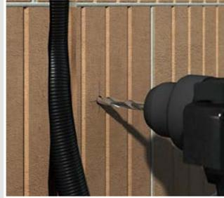
Bohrloch  $\varnothing$  8 mm und mind. 50 mm tief erstellen.
