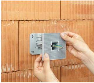
Montageplatte bis zum Anschlag auf den Trägerarm aufsetzen.
