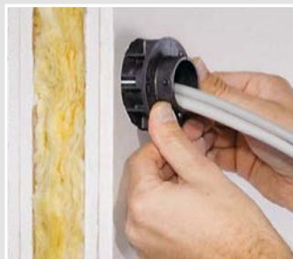
Schottzylinder in die Installationsöffnung eindrücken.
