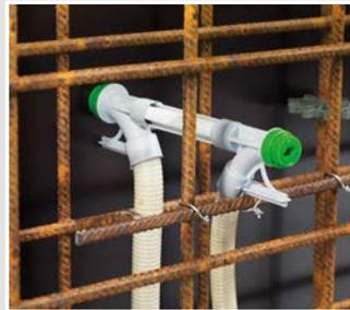
...auch die Installation zur Gegenschalung mit Stützelement und Gegenlager.
