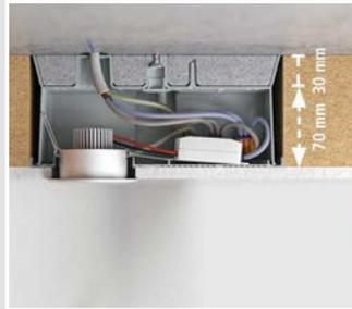
Einbautiefe 70 mm (Dämmstärke 100 mm).
