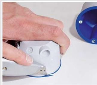
Bei Kombinationen wird einfach der markierte Randstreifen abgetrennt.
