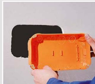
Einführungen ausbrechen, Leitungen einführen, Kasten einsetzen und mit den FX<sup>4</sup> Schrauben befestigen.
