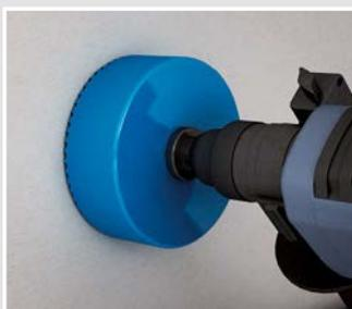
Installationsöffnung mit einem Fräser  $\varnothing$  120 mm (z. B. Bi-Metall Fräser Art.-Nr. 1082-20) erstellen.
