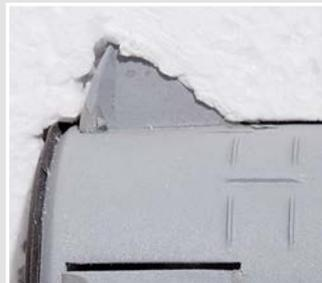
Die Schwenschnitten verankern die Dose stabil in der Dämmung. Die Klemmrippen im vorderen Bereich fixieren die Dose zusätzlich.
