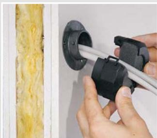
Dichtelement um die Leitungen legen und verschließen.
