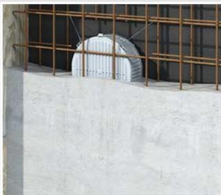
Nach dem Stellen der Gegenschalung kann betoniert werden.
