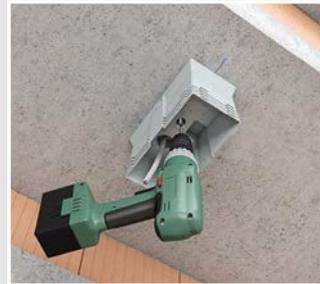
Einbaugehäuse an die Decke anschrauben.
