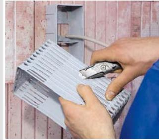
Aufstockelement ggf. an die Dämmstärke anpassen.
