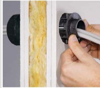
Einfaches Einsetzen des Schottzylinders in die Installationsöffnung.
