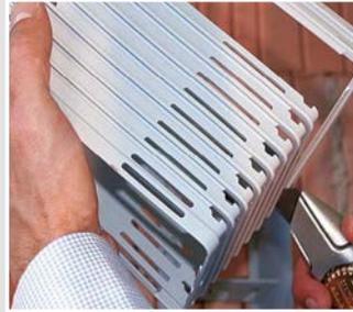
Aufstockelement ggf. an die Dämmstärke anpassen.
