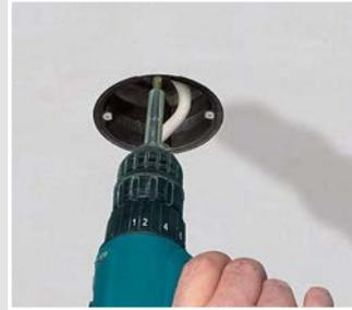
Befestigung der Dosen in bewährter Hohlwandtechnik mit der KAISER FX4-Technik.
