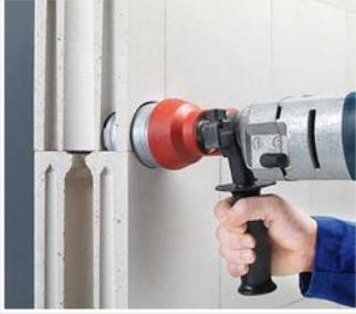
Mit einer Schleifkrone (z. B. Art.-Nr. 1088-02) wird eine  $\varnothing$  82 mm Einbauöffnung erstellt.
