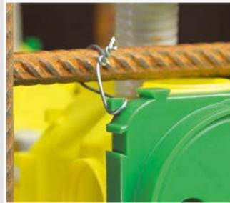
In Erwartung extremer Belastungen sorgen Rödellaschen für die zusätzliche Sicherung.
