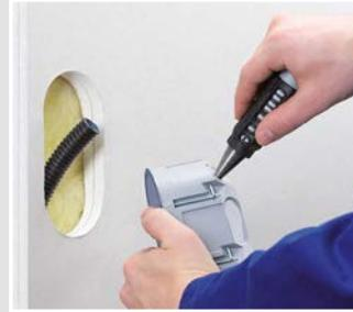
Passgenaue Rohr- oder Leitungsöffnung für die luftdichte Installation mit dem KAISER-Universal-Öffnungsschneider herstellen.
