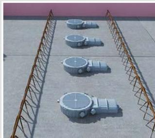
Erstelltes Fertigteilenelement mit integrierten HaloX®-Gehäusen wird auf der Betonbaustelle verlegt.
