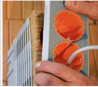
Montageplatte mit Gerätedosen aufsetzen und verschließen.
