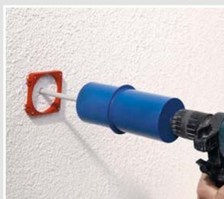
Zentrierhilfe Ø 68 mm und Tiefenanschlag am Fräser sorgen für eine passgenaue Öffnung ohne Beschädigung der vorhandenen Leitung.
