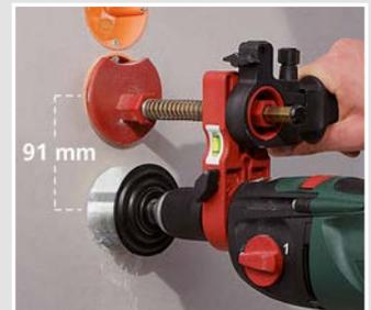
Abstand 91 mm: Zentrierteller in vorhandenes Loch oder Dose setzen, ausrichten und weitere Öffnung fräsen.
