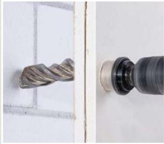
Die Installationsöffnungen können mit handelsüblichen Bohrern (20 mm bzw. 32 mm) in der massiven Wand oder in der Trockenbauwand mit einem Bohrer oder dem Fräser Art.-Nr. 1082-10 (35 mm) erstellt werden.
