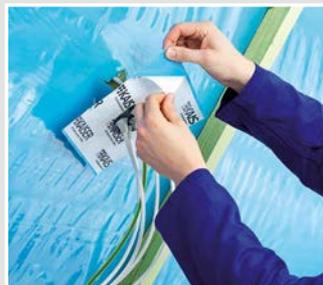
Bevor die Manschette aufgeklebt werden kann, muss sichergestellt werden, dass der Untergrund staubfrei ist. Anschließend Schutzfolie abziehen,...
