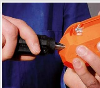
Passgenaue Leitungseinführungen für die luftdichte Installation erstellen Sie mit dem KAISER Universal-Öffnungsschneider (Art.-Nr. 1085-80).
