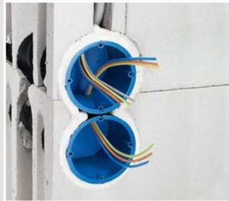
Die schalldichte und vollisolierte Durchverdrahtung erfolgt durch den Verbindungsstutzen.
