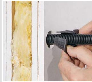
Durch das Aufklappen des Leitungs- und Rohrschotts, kann dieses einfach um Leitung oder Rohr gelegt werden.
