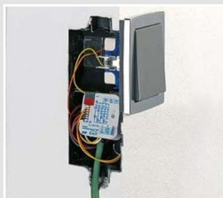
Hier z. B. ein Relais für die zentrale Steuerung mehrerer Jalousie-Antriebe oder eine EIB-Unterputz-Schnittstelle mit einem konventionellen Taster.
