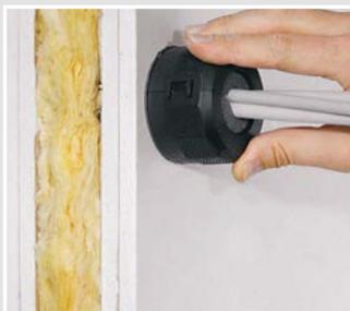
Dichtelement auf den Schottzylinder setzen und mit einer 1/4-Drehung befestigen (Bajonetverschluss).
