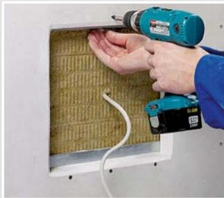
Zuschnitt im unteren befestigten CW-Profil fixieren und mittels Schnellbauschrauben durch die obere Beplankung befestigen.
