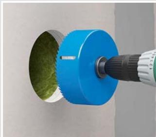
Einbauöffnung mit Bi-Metal-Fräser Art.-Nr. 1082-20 erstellen.
