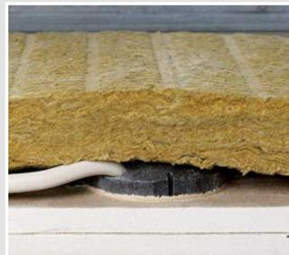
Mit Mineralwolle nach EN 13501 Teil 1 hält die Installation einem Brand bis zur Feuerwiderstandsklasse F60 stand, mit Rockwool/Termark 100 bis zur Feuerwiderstandsklasse F90.
