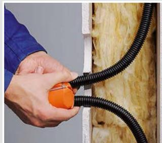
Leitungen bzw. Rohr mit leichter Drehung einführen. Zum einfachen Einsetzen der Dose, Faltpoden zur Mitte eindrücken.
