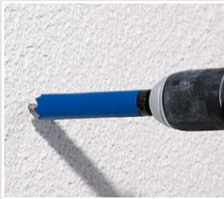
Einbauöffnungen Ø 20 mm erstellen (z. B. KAISER Hartmetall-Fräser mit Tiefenanschlag).
