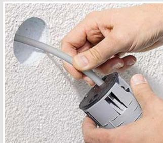
Die elastische Dichtungsmembrane der ECON®-Technik fügt sich beim Durchstoßen winddicht um die Leitung.
