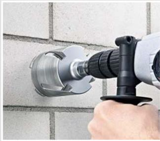
Installationsöffnung je nach Wandstärke mit einer 82 mm Diamant-Schleifkrone oder mit Kernbohrer erstellen.
