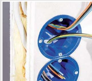
Die dichte und vollisolierte Durchverdrahtung erfolgt mit dem Verbindungsstutzen.
