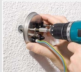
...und bieten einen Toleranzausgleich von bis zu 10 mm. Somit lassen sich alle Anbaugeräte auch nachträglich exakt ausrichten.
