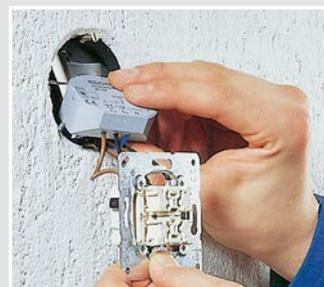
Verdeckter Einbau von Elektronik-Komponenten wie Funkmodul, EIB-Aktor, Notbeleuchtung oder Kabellängen in der Datennetzwerktechnik.
