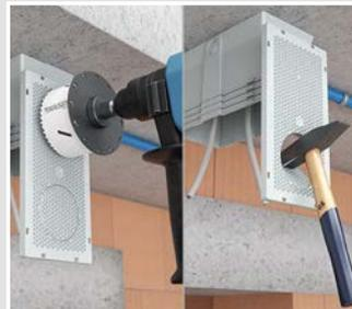
Einbaudurchmesser 68 mm zum Einschlagen, Einbaudurchmesser bis 86 mm zum Ausfräsen.
