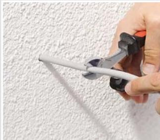
Es ist sicherzustellen, dass die Leitung durch die Dämmstoffplatte geführt wurde. Die vorhandene Leitung auf ca. 10 cm kürzen.
