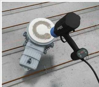
Montage des einteiligen Gehäuses mit Mineralfaserplatte...
