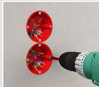
Befestigung der Dosen in der Einbauöffnung.
