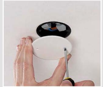
Der Brandschutzdeckel erhält bei F30 Decken die Feuerwiderstandsklasse F30, bei F90 Decken die Feuerwiderstandsklasse F90.
