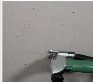
...anschließend den Ausschnitt für das Gehäuse erstellen und zur späteren Verwendung aufbewahren.
