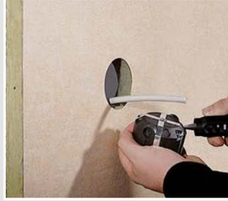
Leitungseinführung mit dem KAISER Universal-Öffnungsschneider öffnen.
