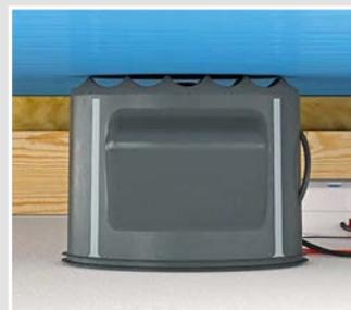
Rückseitige Oberflächenstruktur sorgt für minimale Auflage der Dampfbremse und für eine optimale Wärmeabführung.
