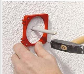
Die KAISER Zentrierhilfe Ø 68 mm Art.-Nr. 1090-68 mit Stahlnägeln am WDVS befestigen.
