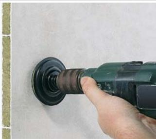
Bei Wandaufbauten mit mineralischen Baustoffen sorgt der Fräser (Art.-Nr. 1084-10) für schnelles, einfaches Arbeiten. Er fräst die erforderliche Wandbohrung von Ø 74 mm und schafft die Basis für eine exakt wandbündige Dosenmontage.
