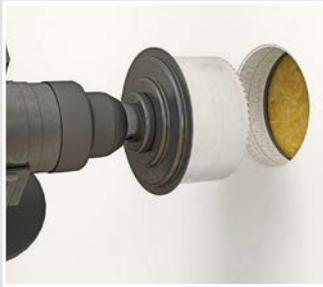
Mit einem Fräser (z. B. MULTI 4000: Art.-Nr. 1084-10) wird eine  $\varnothing$  74 mm Öffnung erstellt.
