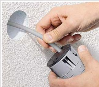
Die werkzeuglose und winddichte Leitungseinführung vermeidet Zugluft entlang der Leitung.
