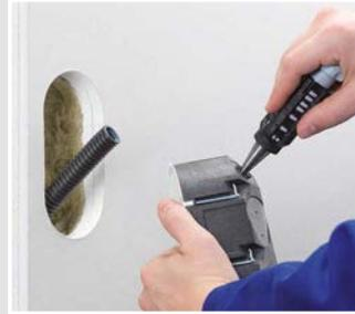
Passgenaue Rohr- oder Leitungsöffnung für die rauchdichte Installation mit dem Öffnungsschneider und / oder mit dem Stufenbohrer oder Aufreiber herstellen.
