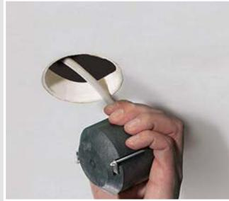
Die passgenaue Öffnung für die Leitung wird mit dem KAISER Universal-Öffnungsschneider hergestellt.
