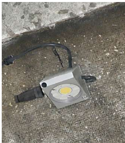
Luminaire WILSON-DOWNLIGHT développé spécialement pour ce projet
