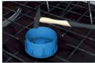
Lüftungshülse auf die Schalung nageln.
