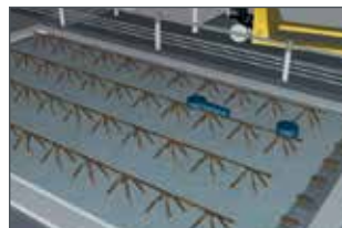
Stahlarmerung wird eingebracht und der Beton gegossen.
