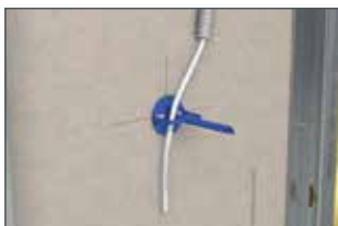
Aufkleben und Kabel durchziehen.
