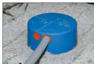
M20 oder M25-Rohr einschieben.
