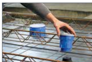
2. Variante: Mit Magnet auf Schaltisch positionieren.
