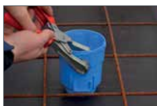
Universaldose mit Nägeln auf die Schalung fixieren. Loch mit Stanzzange ausstanzen.
