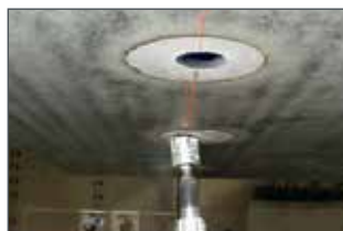
Individuelle Öffnungen können ausgebohrt werden.
