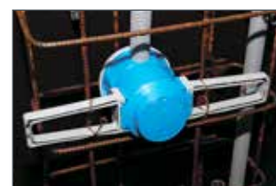
Montage als Elektronikgroßdose mit Flügeln.
