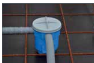
Montage als Deckengroßdose.
