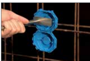
Deckel mit dem Primo-Nagler auf Schalung nageln.
