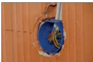
Unterteil bündig setzen. Elektrokabel oder Rohre einbringen.
