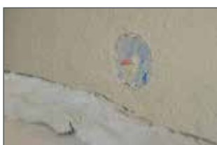
Der Putzer drückt das Dosenoberteil putzbündig.
