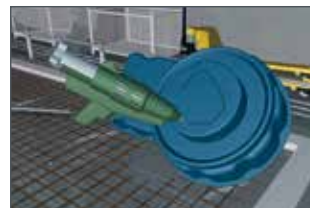
XXL Flexgroßdose mit Heißkleber auf den Schaltisch kleben.
