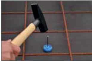
Unterteil auf Schalung nageln.
