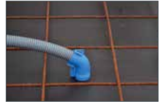
Krümmter auf das Unterteil stecken.
