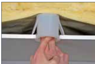
Schutzkappe in Bohrloch einschieben.
