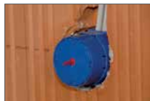
Deckel steht noch ca. 2,5 - 3 cm vor.
