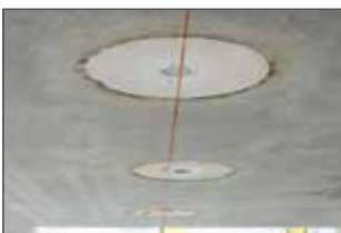
Linie anzeichnen, Ungenauigkeiten durch \varnothing 190 mm leicht korrigierbar.
