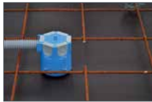
Fertig – absolut dicht, sichere Zugentlastung!
