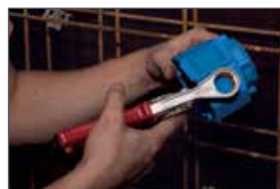
Rohrlöcher ausbohren oder mit Stanz- zange ausstanzen.
