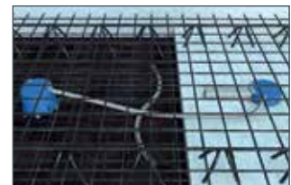
Stahlarmierung wird eingelegt und Beton gegossen.
