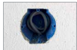
25 Sekunden für 5 Dosen ausbohren und Deckel entfernen.
