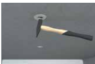
Deckel mit Hammer einschlagen.
