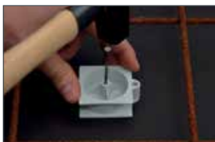
Unterteil auf Schalung nageln.
