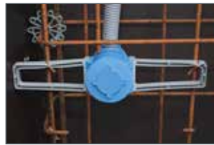
Leuchtenauslassdose Ø 35 mm mit Flügeln montiert.
