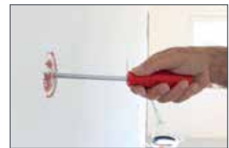
Zum Schluß mit einem Schraubenzieher den Putzdeckel entfernen.
