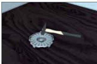
Deckel mit Nägeln auf der Schalung befestigen.
