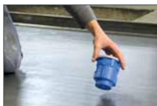
1. Variante: Mit Heißkleber auf Schaltisch kleben.
