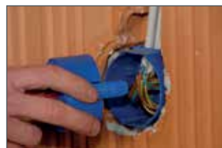
Dosendeckel einrasten lassen.
