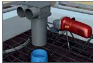
Deckenstützen auf die gewünschte Länge kürzen.
