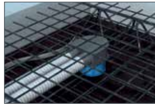
Obere Bewehrung einbringen und betonieren.
