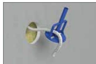
Leitungsträger rausziehen.
