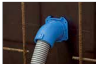
Montage mit Nägeln auf der Schalung.
