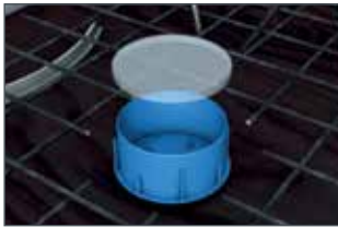
Schutzdeckeln von Lüftungshülse entfernen.
