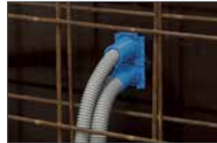
Montage mit Nägeln auf der Schalung.
