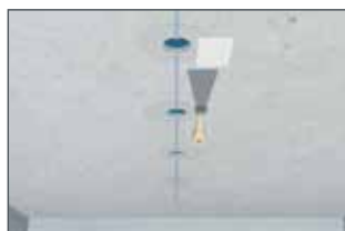
Mit einem Lochsneider wird die individuelle Öffnung ausgebohrt und an die Mineralfaserplatte angespachtelt.
