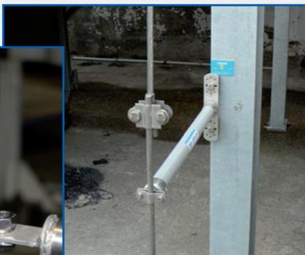
**Isoliertraverse** zur Befestigung an Ecken und Gebäudekanten.
