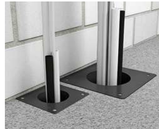
Mantelleitungen und/oder Rohre durch die Montagehülse führen.
