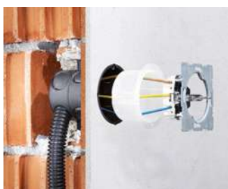
Nachträgliches, luftdichtes Verschließen von Unterputzdosen.
