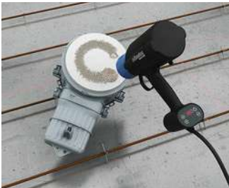
Montage des einteiligen Gehäuses mit Mineralfaserplatte...
