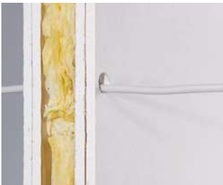
Installationsöffnung Ø 20 mm mit einem Fräser (z. B. KAISER Hartmetallfräser Art.-Nr. 1088-06) oder einem Bohrer erstellen.
