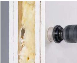
Installationsöffnung Ø 35 mm z. B. mit dem KAISER Fräser MULTI 4000 (Art.-Nr. 1082-10) erstellen.
