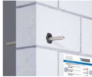
Wanddurchführung durch Brandschutzwand aus Kalksandstein.
