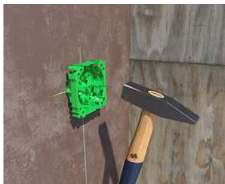
Frontteil an der Arbeitsschalung befestigen.
