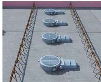
Erstelltes Fertigteillement mit integrierten HaloX®-Gehäusen wird auf der Betonbaustelle verlegt.
