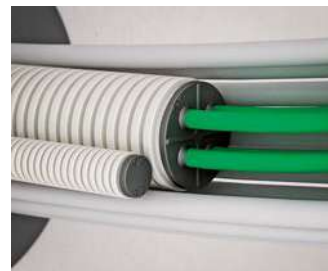
Installationsrohre dürfen als Reserverohre eingeführt werden.
