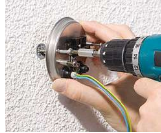
...und bieten einen Toleranzausgleich von bis zu 10 mm. Somit lassen sich alle Anbaugeräte auch nachträglich exakt ausrichten.
