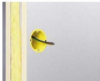
Einbau der Strahlenschutzdose in der Wand.
