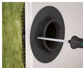
Schottzylinder, wie bei Hohlwanddosen, durch das Anziehen der Laschenschrauben befestigen.
