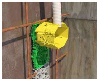
Rückteil mit Rohr auf das Frontteil aufrasten und Rohr einlegen.
