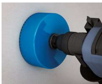
Installationsöffnung mit einem Fräser Ø 120 mm (z. B. Bi-Metall Fräser Art.-Nr. 1082-20) erstellen.
