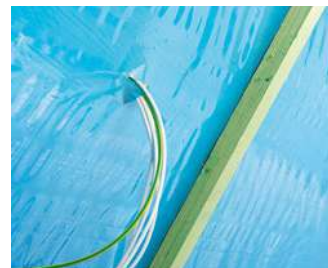
Die Leitungen werden durch die Luftdichtung des Gebäudes geführt. Diese Durchführung muss dauerhaft luftdicht verschlossen werden.
