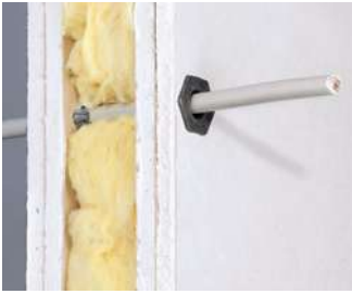
Wanddurchführung durch Trockenbau-Brandschutzwand.
