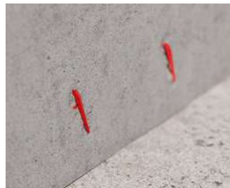
Signalborste - einfaches Wiederfinden der Übergänge in der Wandoberfläche.
