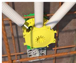
Die Rohre können nun einfach in die vorbereiteten Öffnungen eingebracht werden.
