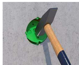
Nach dem Betonieren, Betonbaudosen oder -kästen öffnen, anschließend Geräte oder Deckel montieren.
