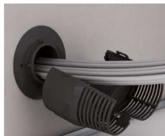
Dichtelement aufklappen und entfernen.
