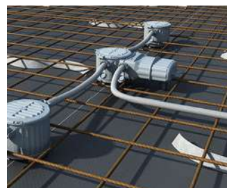
Darstellung Gruppenschaltung mit einem Betriebsgerät für mehrere Leuchten.
