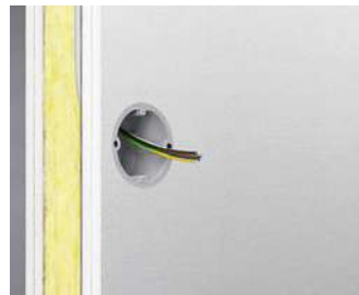
Einsatz der Strahlenschutzdose in der Wand.
