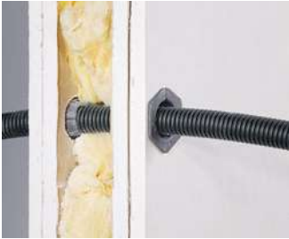
Wanddurchführung durch Trockenbau-Brandschutzwand.
