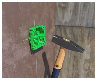
Befestigung mittels Stahlnägeln.
