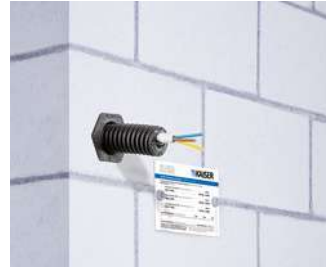
Wanddurchführung durch Brandschutzwand aus Kalksandstein.
