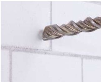
Installationsöffnung mit einem Ø 32 mm Bohrer erstellen.
