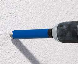
Einbauöffnungen Ø 20 mm erstellen (z. B. KAISER Hartmetall-Fräser mit Tiefenanschlag).
