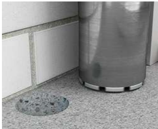
Erstellung einer Kernlochbohrung 150 mm oder 100 mm.
