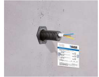
Wanddurchführung durch Brandschutzwand aus Beton.
