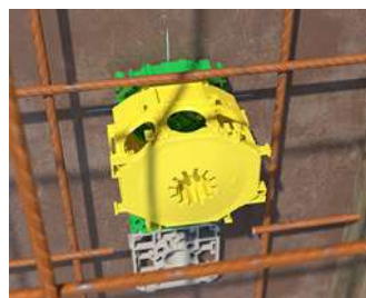
...den rückseitigen Deckel vor dem Einbringen der Rohre verschließen.
