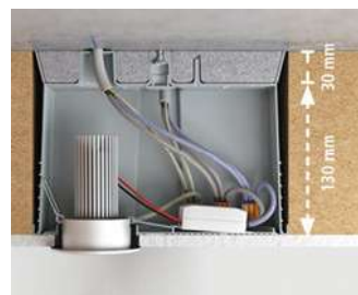
Einbautiefe 130 mm (Dämmstärke 160 mm).
