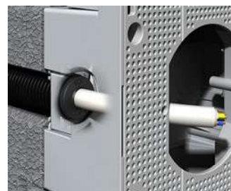
...und das Rohr mit einem Dichtstopfen versehen.
