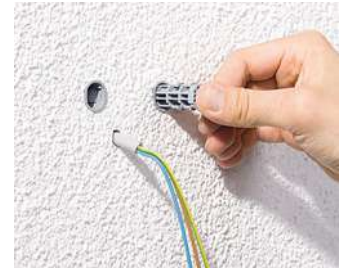
Den Befestigungskern eindrücken bis er in der Ankerhülse verrastet.
