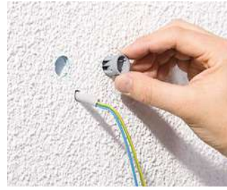
Die Ankerhülse des Mini-Geräteträgers wandbündig in die Einbauöffnung eindrücken.
