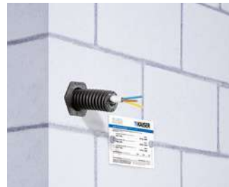
Nach der Montage des Schotts das Schott-Kennzeichnungsschild anbringen.
