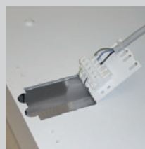
3 Anschlussleitung in Klemme einführen
