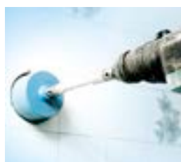
Kernbohrung in der Wand
