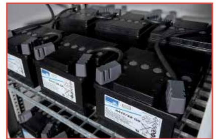
Bei Netzausfall versorgt Powerpack die Verbraucher durch hochwertige Industriebatterien.
