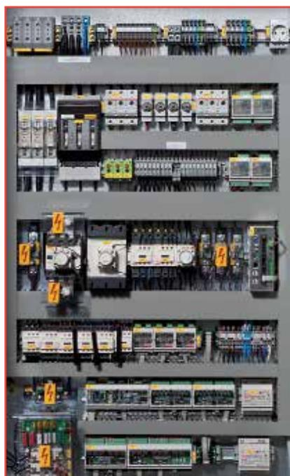
Im Steuerschrank befinden sich der Ladegleichrichter, die kompletten Steuer- und Schalteinrichtungen gemäß DIN VDE 0108-100 sowie das Anschlussfeld mit Sicherungen für Netz und Verbraucher.
