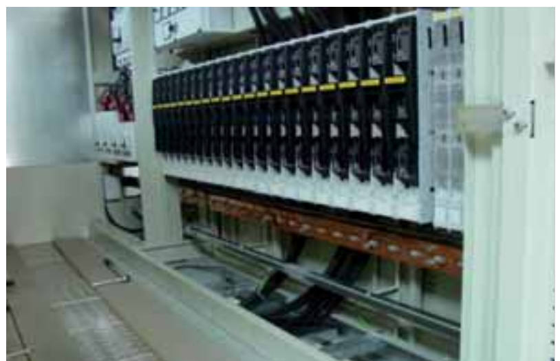
Beispiel Ausführung Niederspannungsverteiler
