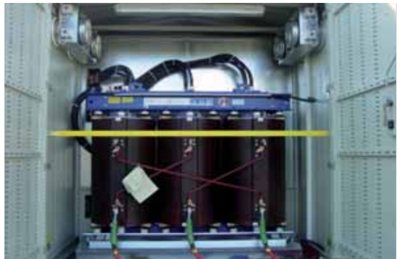
Beispiel Ausführung Transformatorraum
