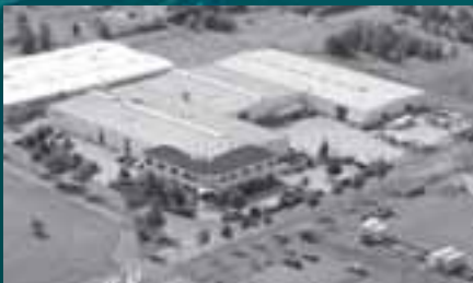
BOSECKER VERTEILERBAU SACHSEN GMBH, ZITTAU
