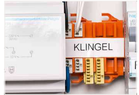
Anwendung für eine Hausklingelanlage – Befestigung auf Tragschiene 35
