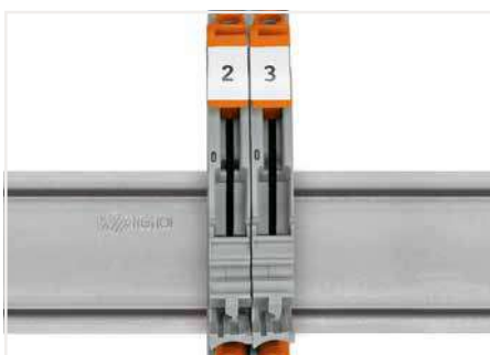
Kurzschluss für Stromwandler-Prüfschaltungen vorbereiten.
