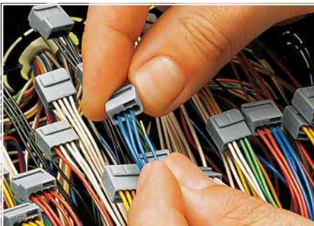
Anschließen: Abisolierten Leiter bis zum Anschlag hineinstecken.
