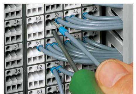
Leiter mit Aderendhülsen anschließen.
