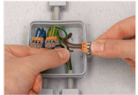
Anschließen: Abisolierten eindräftigen Leiter bis zum Anschlag einstecken.
