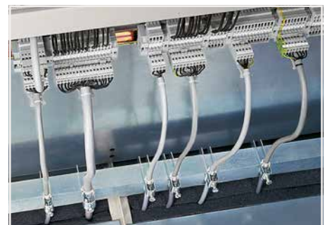
Kabeleinführung im unteren Bereich des Schaltschranks Separate Zugentlastung, abgedichtet mit Moosgummiplippen an verschiebbaren Bodenblechen, für Schutzart IP54 (z. B. Fa. Rittal)
