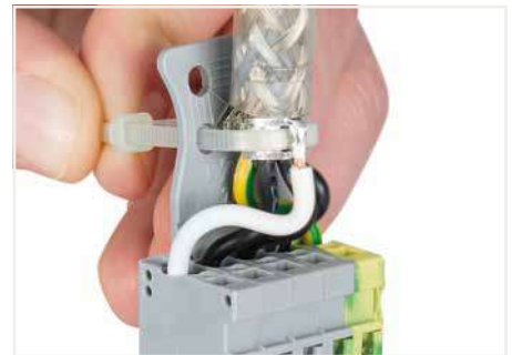
Mittels Kabelbinder den Schirmleiter und die Schirmübergabe an der Zugentlastungsplatte befestigen.
